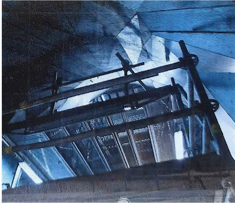
(fig.263) Interior de la estructura de la escultura "Puppy" con su andamiaje de cinco alturas.
