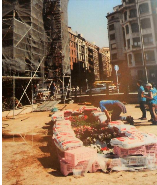
(fig.270) Labores de preparación para ubicar después las plantas.
