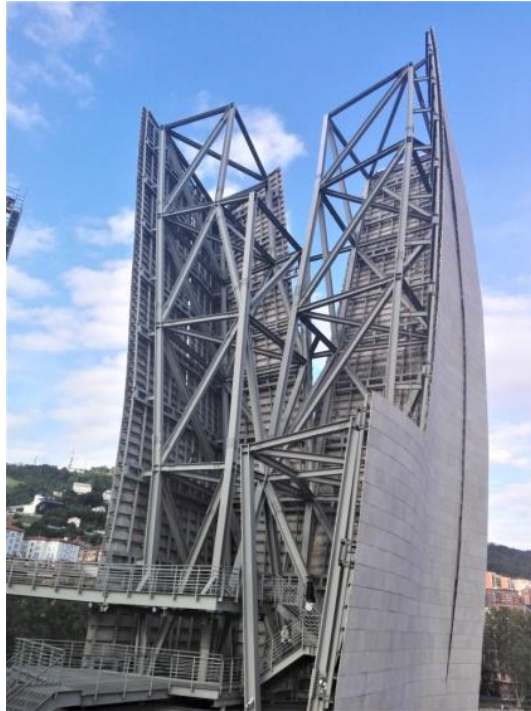
(fig.44) La torre con la que remata el gran volumen de titanio que envuelve por debajo al Puente de la Salve dejando los huesos de acero vistos (fotografía de la autora).
