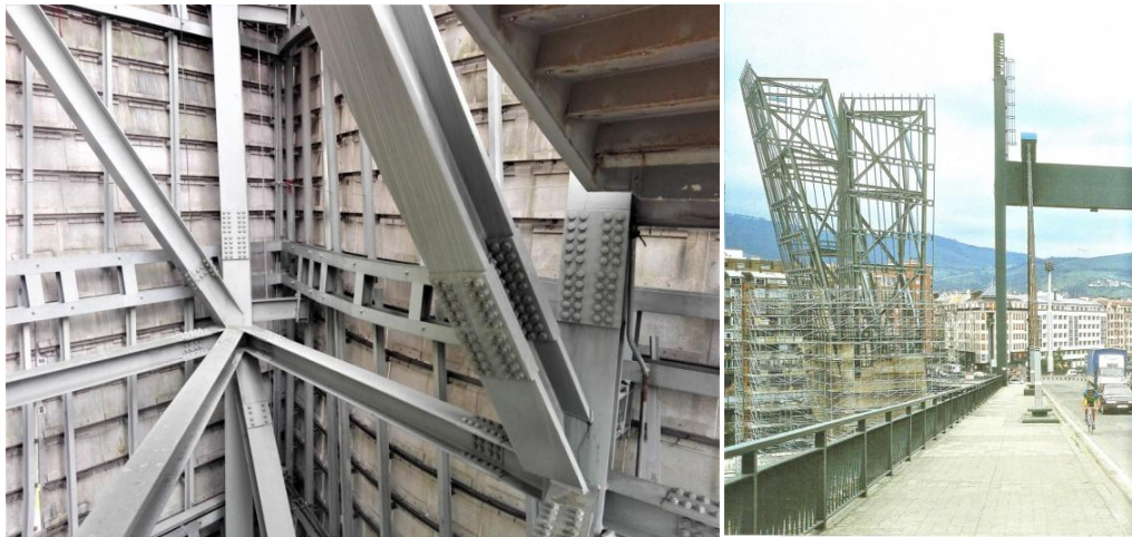
(figs.46 y 47) Izquierda: Vista en la actualidad de la estructura de acero galvanizado de la torre con la que remata el volumen que envuelve el Puente inferiormente, adquiriendo un fuerte carácter escultórico el conjunto. Derecha: la misma torre en construcción totalmente desnuda equilibrando el peso visual del atirantado del Puente de la Salve. Después se cubriría parcialmente con piedra caliza.
