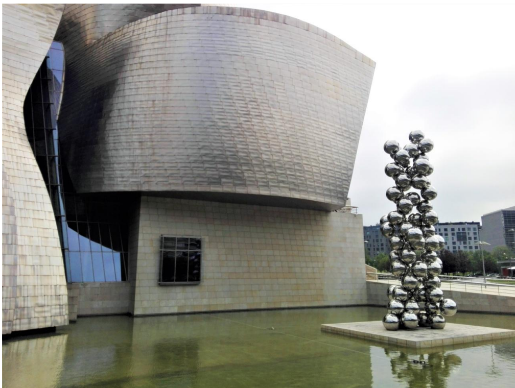
(fig.326) Vista de la obra en el jardín de agua de la fachada norte del Guggenheim Bilbao (fotografía de la autora).
