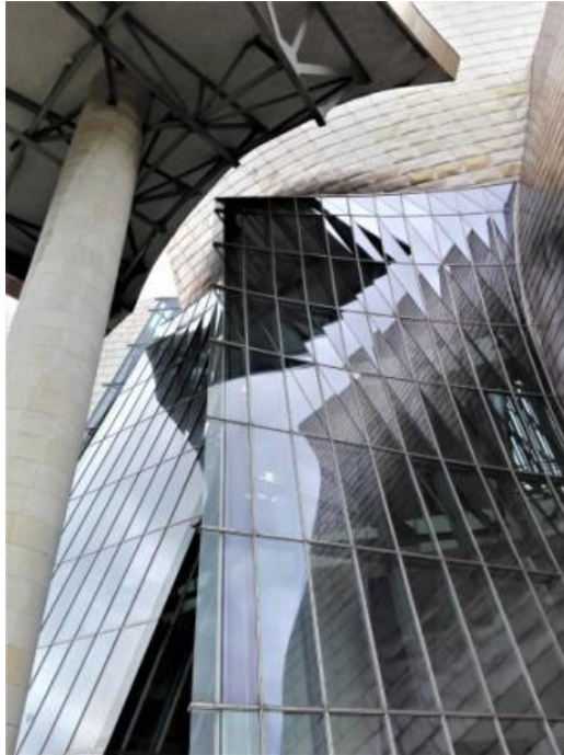
(fig.51) Muro cortina de la fachada norte del Guggenheim Bilbao (fotografía de la autora)
