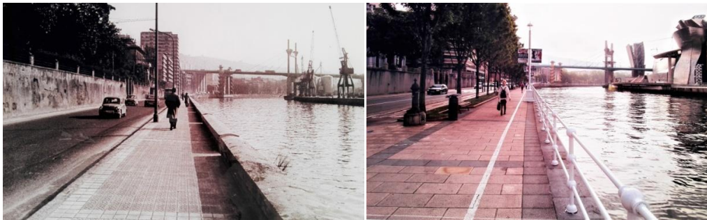
(figs.17 y18) Vista de la Avenida de las Universidades, la ribera de la Ría y al fondo el Puente de la Salve con las grúas que ocupaban es espacio que ahora ocupa el Museo Guggenheim Bilbao, ca. 1970
