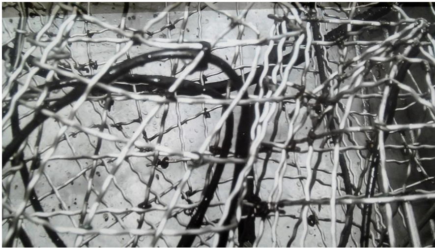
(fig.266) Entramado del mallazo sobre la estructura metálica sin la turba.
