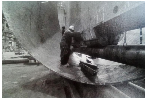
(fig.100) Máquina curvadora Hugh Smith en Beth Ship (Maryland). Beth Ship quebraría y cerraría en 2003 y finalmente Serra encontraría en Siegen (Alemania) la empresa constructora e ingenieril Pickhan Umformtechnik GmbH con la capacidad de entender y adecuarse a sus deseos.
