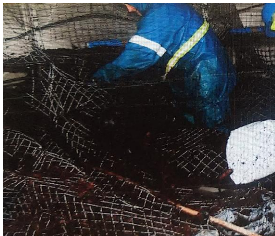
(fig.267) Un operario realiza labores de colocación y sujeción de la turba.
