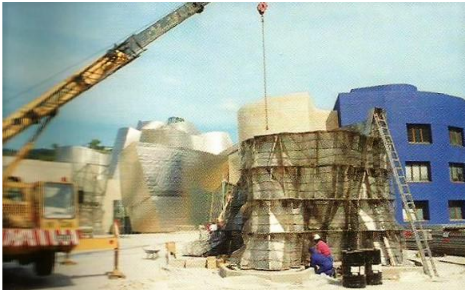
(fig.262) Montaje de la estructura de acero inoxidable de Puppy con el Museo Guggenheim Bilbao al fondo.
