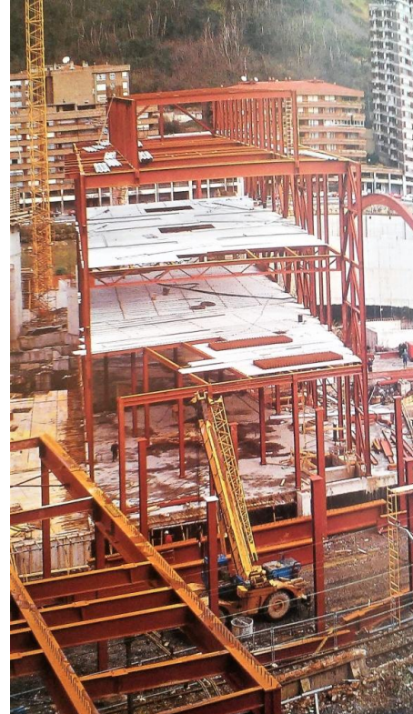
(figs.44 y 45) Labores de montaje de la construcción con el esqueleto industrial.
