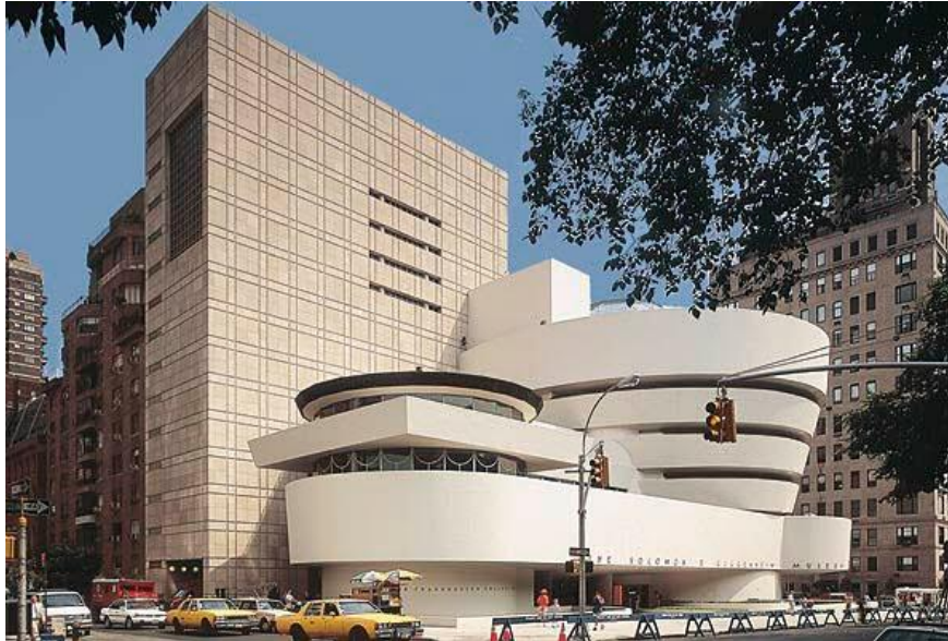
(fig.4) Vista del exterior del Museo Solomon R. Guggenheim de Nueva York en la actualidad con la ampliación realizada en 1992 por Gwathmey Siegel & Associates en forma de paralelepípedo consiguiendo añadir 4700 metros cuadrados más de espacios expositivos y 1400 metros cuadrados de superficie para oficinas al edificio de Wright con sus originales 4.738 metros cuadrados.
