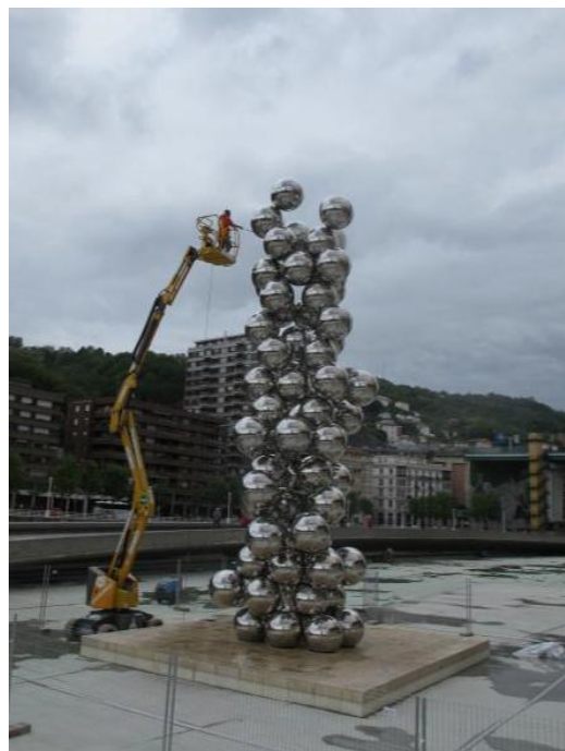
(fig. 325) Realizando labores de limpieza y conservación.
