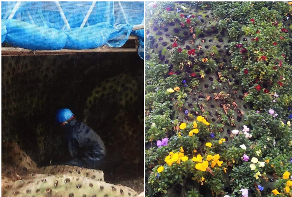
(figs.268 y 269) Un operario trabajando en las labores de colocación del manto geotextil y vista parcial del tejido verde en cuyos orificios se introduce cada una de las 38000 plantas que componen el "pelaje" de la escultura. (fig.24 Fotografía de la autora).
