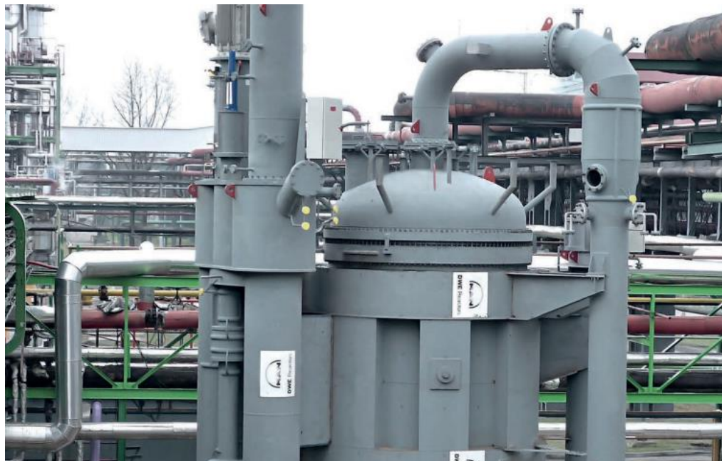
Ilustración 18: Reactor tubular catalítico modelo DWE ® de la empresa MAN (Fuente: MAN)
