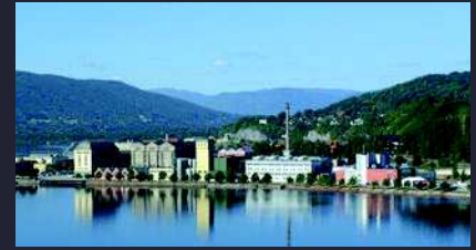
Nel Hydrogen Electrolyser NOTODDEN - NORWAY
