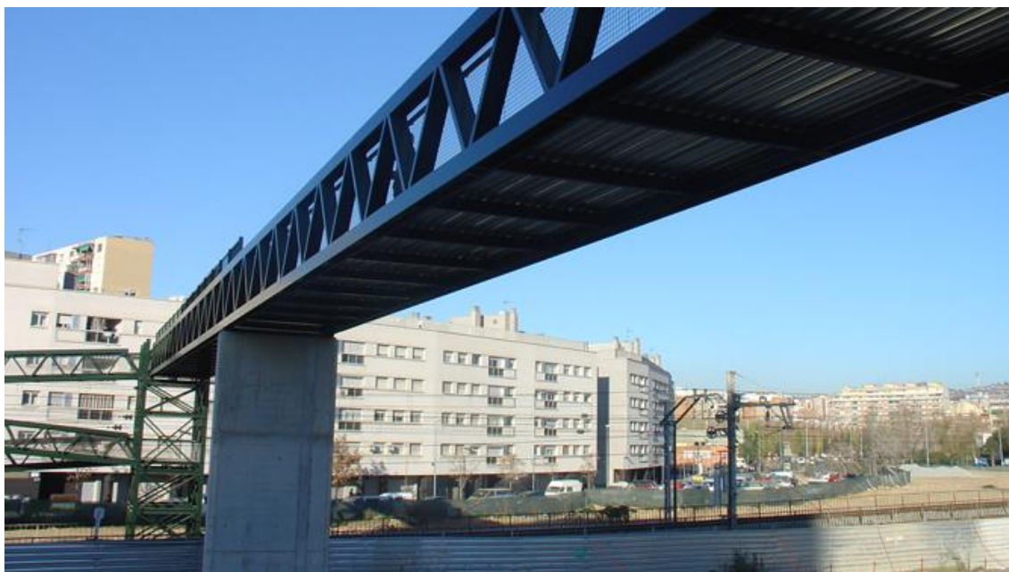
10.Irudia: Tablero metalikoa eta hormigoizko pilareak dituen zaldaina. Campoamor zaldaina L'Hospitalet de Llobregat-en, Bartzelonan.
