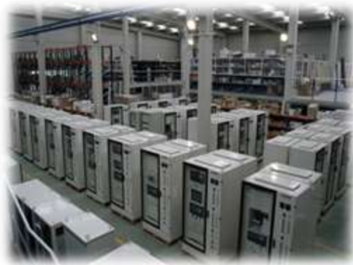
Figura 7.19 Taller de cuadros de eléctricos de Tecuni S.A.
