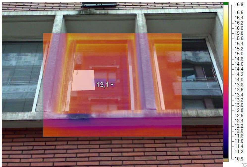
Fotografía 28: Termografía de ventana de la Planta 1 desde el exterior del edificio
