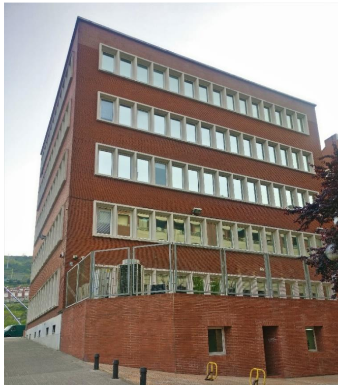
Fotografía 2: Fachada trasera del edificio
