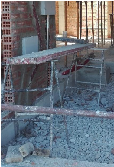
Asto aldamia (ezker) eta aldamio tubularra (eskuin)
