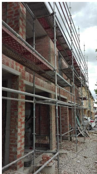
Asto aldamia (ezker) eta aldamio tubularra (eskuin)
