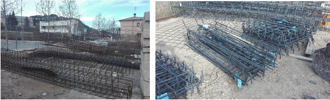
Zimenduen armatuaren metaketa
