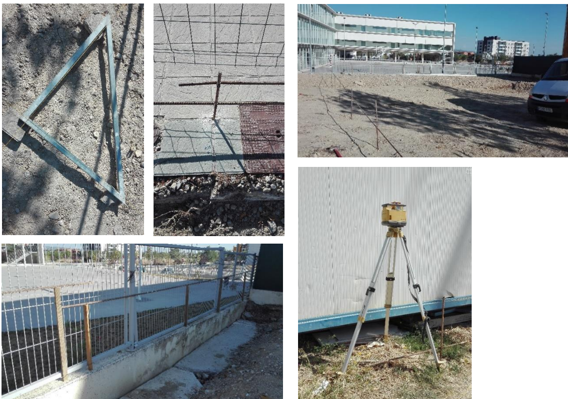
Lursaila markatzea planoetako dimentsioak kontutan hartuta
