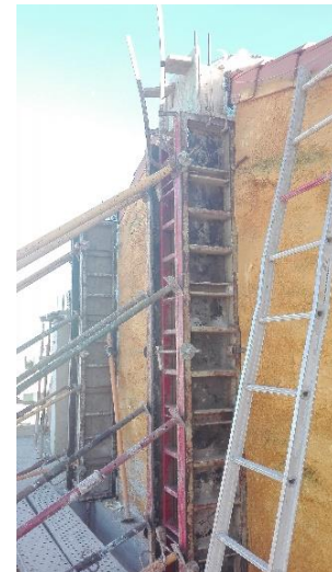
Eskuzko eskailera metalikoa
