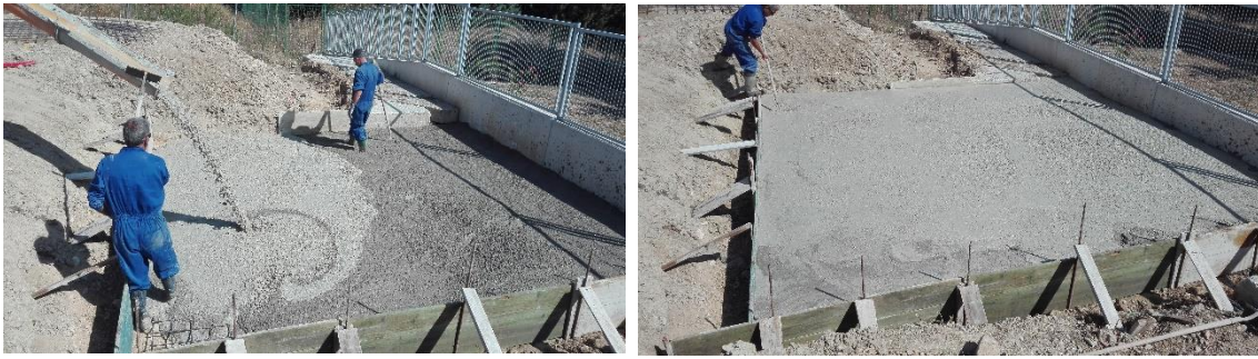
Garabiaren zapataren eraikitze prozesua
