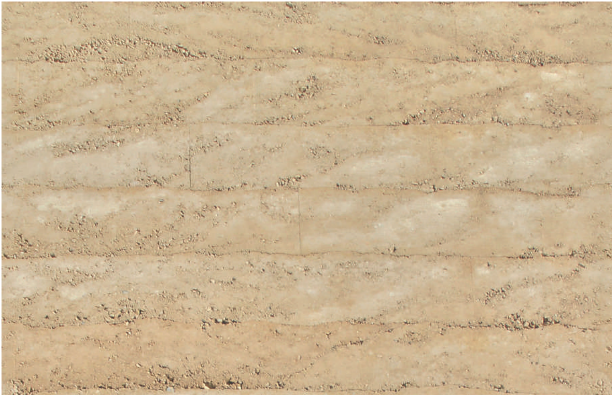
Hormigón apisonado coloreado en la masa Béton damé teinté dans la masse
