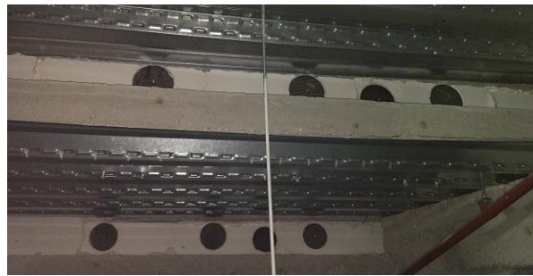
Figure 20: Bouches de soufflage d'air entre les marches des amphithéâtres
