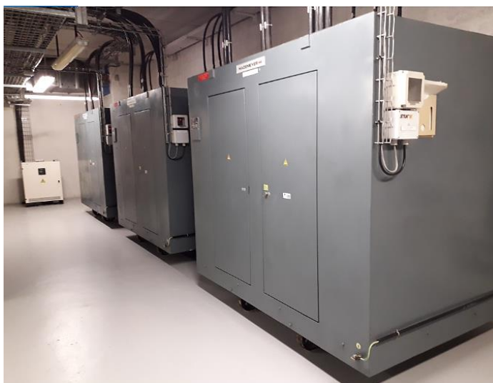
Figure 12: Transformateurs HT/BT
