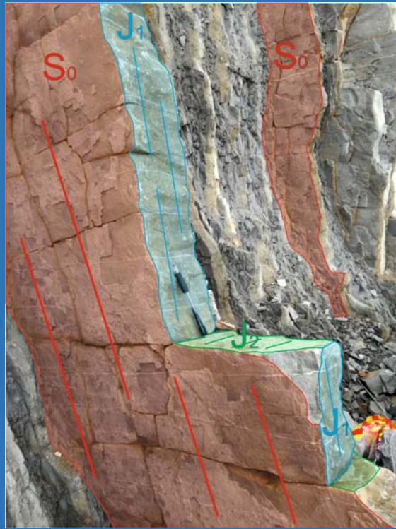
Figura 18. Principales familias de planos de discontinuidad de los acantilados de Itzurun ( S_0 : estratificación; J_1 : Discontinuidad 1; J_2 : Discontinuidad 2).
