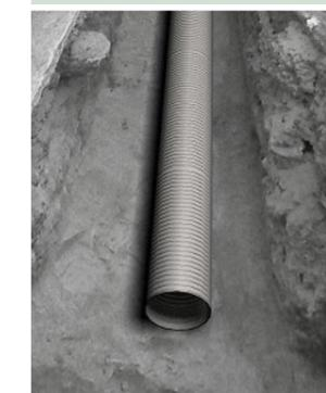
La **red** se efectuará a base de **tubos de PVC**, con una pendiente mínima de 1% para los colectores colgados y del 2% para los enterrados, y los diámetros establecidos en el plano de saneamiento.
