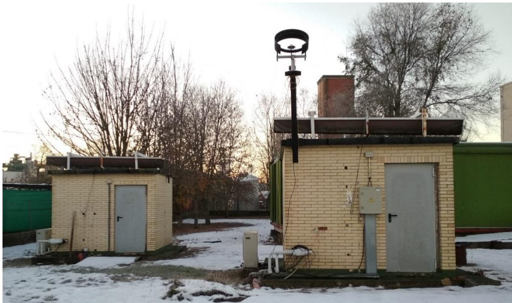
Figura 4-3: Exterior casetas de ensayo del LCCE
