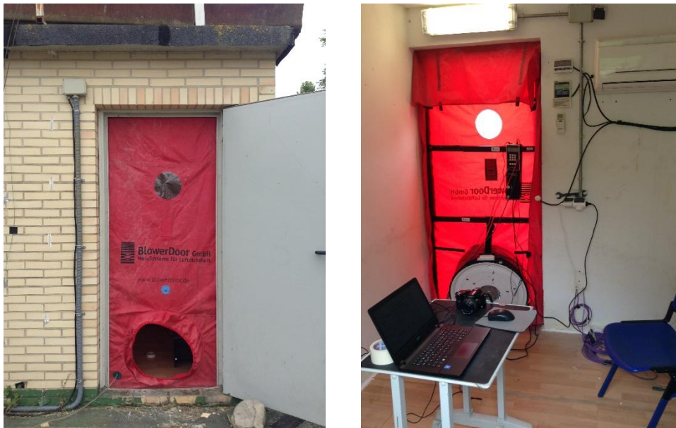
Figura 4-5: Ensayos de Blower Door realizados en las casetas de ensayo
