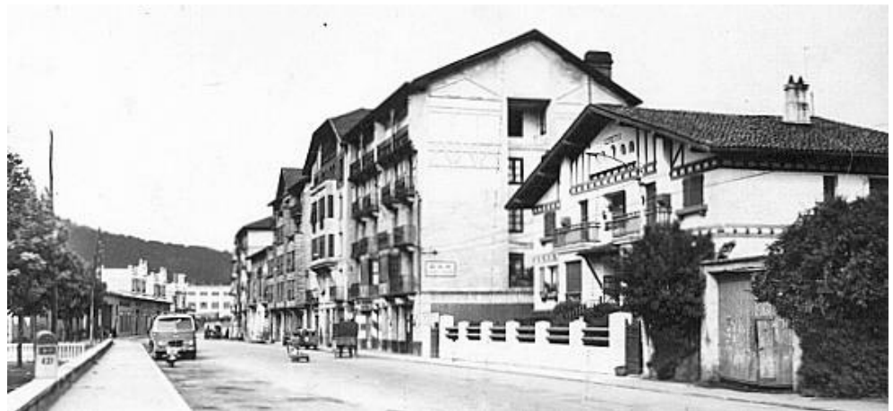
Fig. 3.35: Vista de la avenida Navarra donde se observan, a la izquierda, los edificios construidos para acoger las industrias complementarias citadas en el texto. (Martín García)
