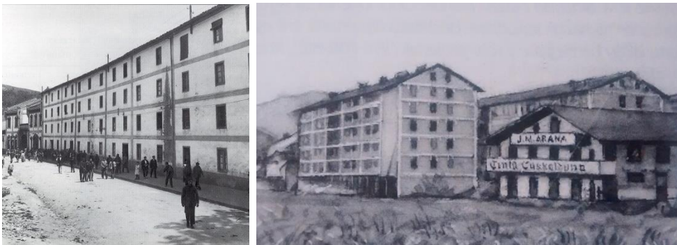
Fig. 3.27: Viviendas de obreros de SECM. y el ensanche de Bideluze en 1908, donde se observa la fábrica de tintas de J.M. Arana. (GureGipuzkoa)
