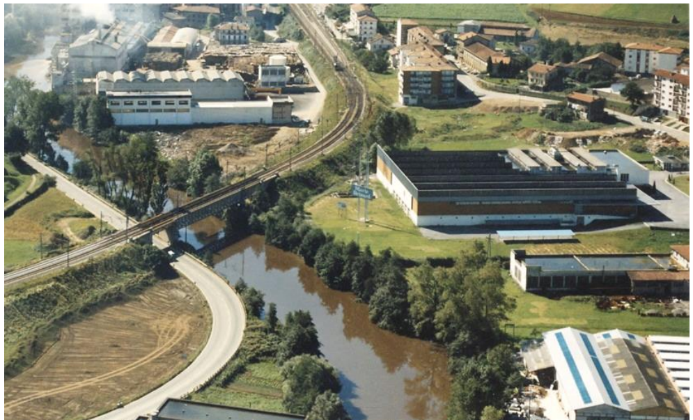
Fig. 3.225: Pabellones en el ámbito de Elbarrena. (AMV)
