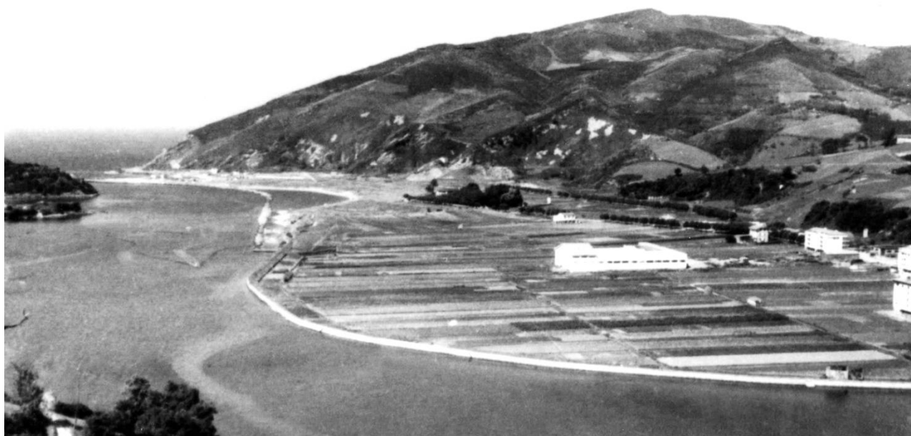
Fig. 3.329: Zona de Palotas donde se observa la fábrica de Dentici. (AFO ORIO0205)
