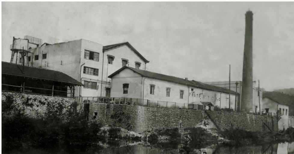
Fig. 3.219: Fachada al río de la fábrica papelera "Portu y Cía". (AMV)
