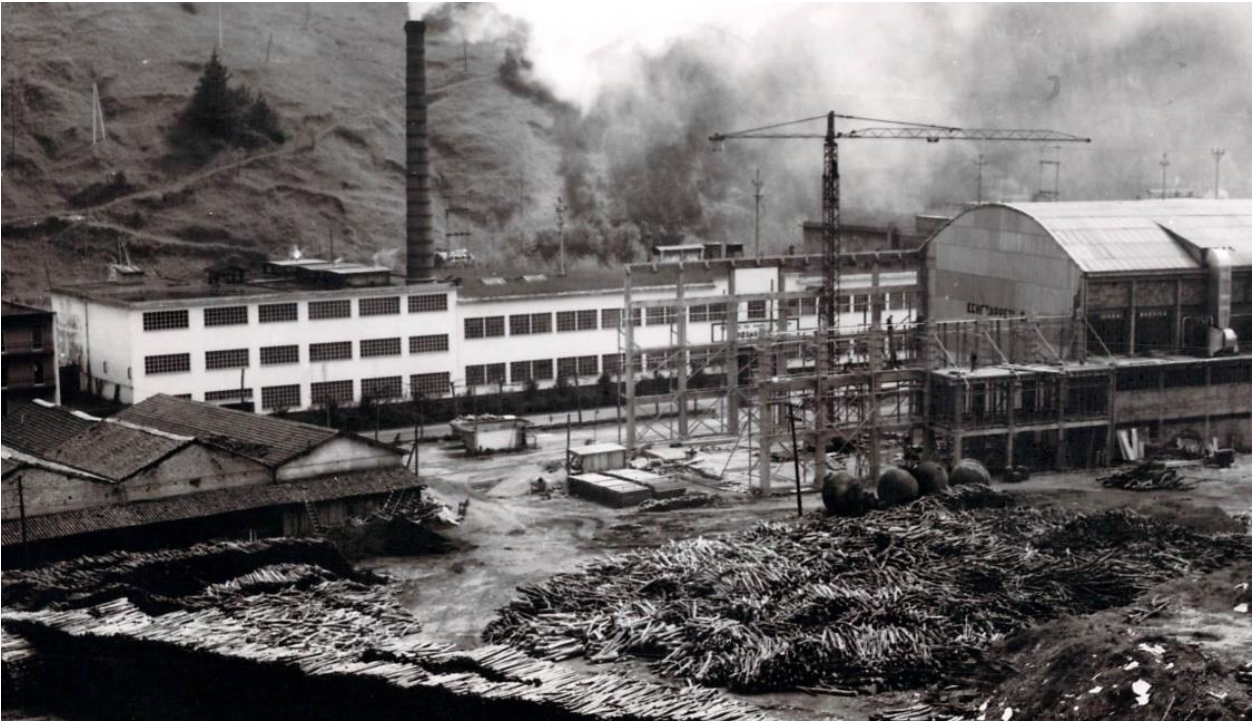
Fig. 3.170: Apeas de pino y haya en el solar y, al fondo, las lejiadoras esféricas obsoletas desinstaladas. (AEPE F 631)
