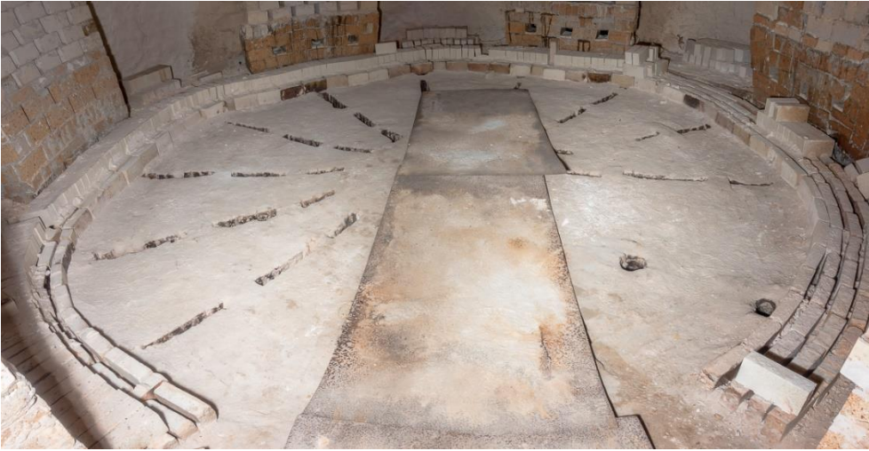
Fig. 3.368: Suelo de la cámara superior del horno 3. (Ana Vitoria)
