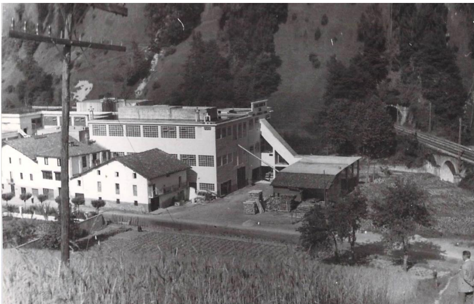
Fig. 3.126: El edificio para pasta mecánica recién construido. (AEPE F 532)
