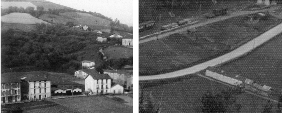
Fig. 3.110: Pabellones de la fábrica de jabón de Garro y el pabellón de la carpintería mecánica de "Iraola e Iriondo". (Ayto. Legorreta)
