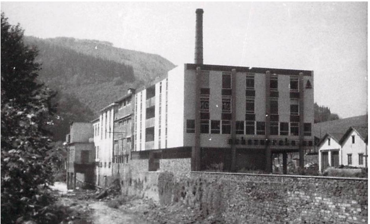
Fig. 3.140: El conjunto encabezado por el edificio de oficinas y viviendas visto desde el extremo norte. (AEPE F 547)
