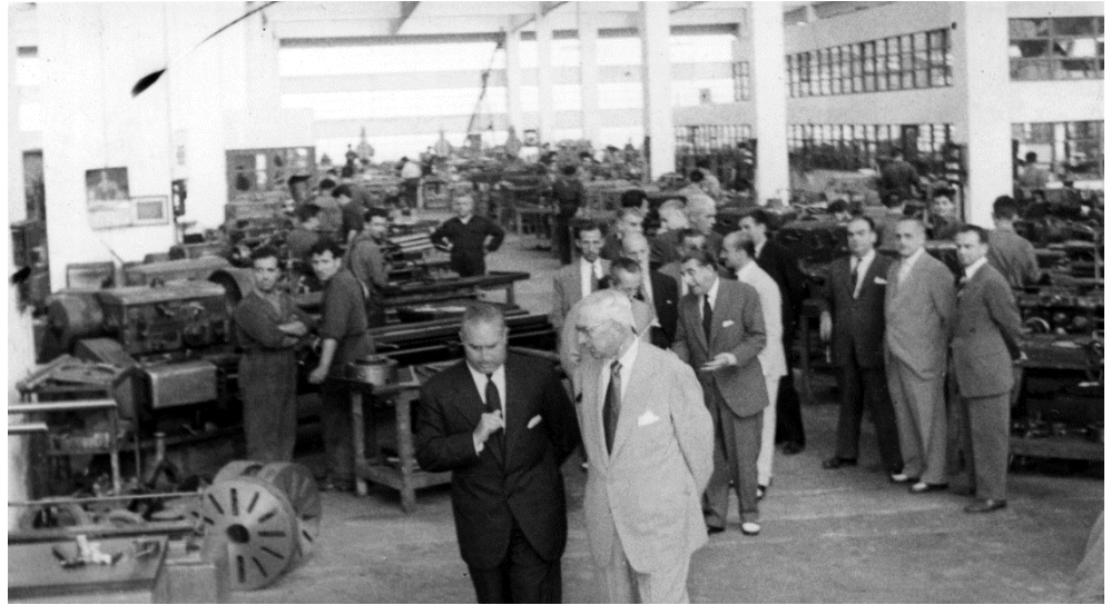
Fig. 3.268: Visita oficial en el interior del pabellón primitivo: imagen transversal de la segunda crujía. 1950. (AMV)
