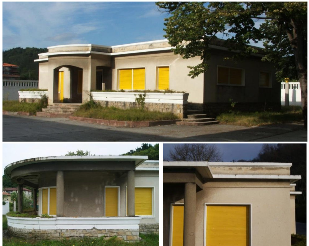
Fig. 3.347: Imágenes del exterior del edificio de oficinas construido. (Elaboración propia)
