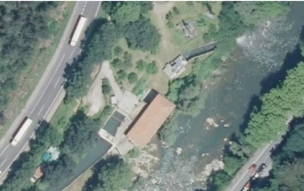
Fig. 3.311: Ortofoto de 2015 donde se observa la casa de turbinas, el parque de transformación y el canal de descarga implantados en 1986. (GeoEuskadi)
