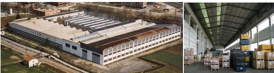
Fig. 3.259: Imagen panorámica del conjunto con la ampliación proyectada en 1972 y su interior. (AMV; Elaboración propia)
