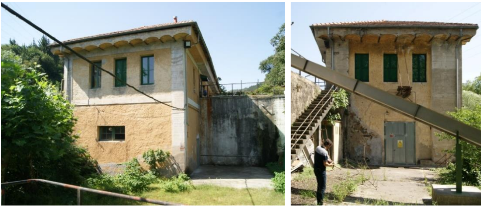
Fig. 3.298: Fachadas laterales de Electra Abaloz. (Elaboración propia)
