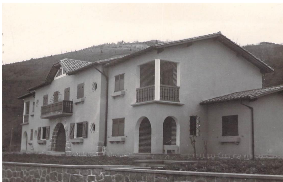
Fig. 3.106: Uno de los bloques del barrio Echezarreta. (AEPE F 606)
