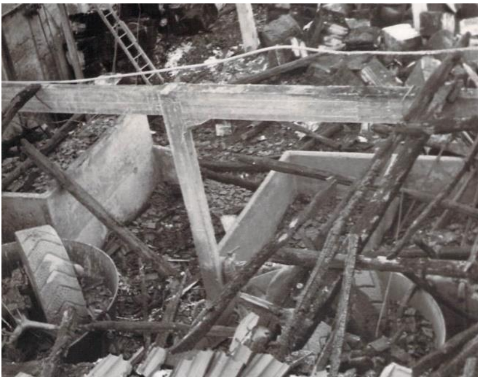
Fig. 3.167: Instalación para preparado de pasta al interior del pabellón incendiado. (AEPE F 510)
