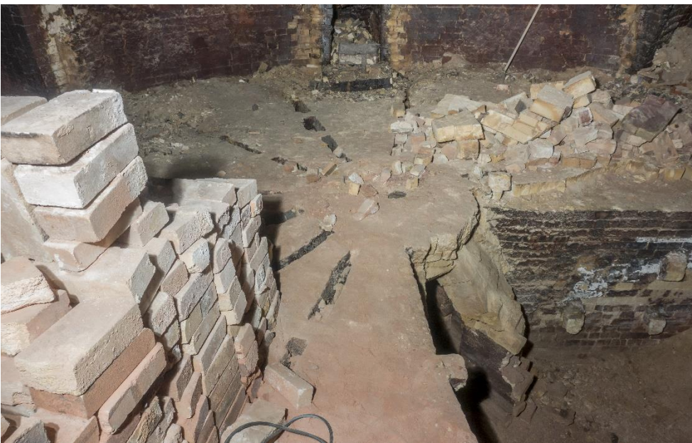
Fig. 3.369: Suelo de la cámara superior del horno 1 medio derribado. (Ana Vitoria)
