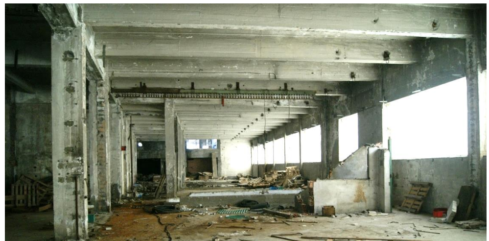
Fig. 3.186: Interior de la fábrica: primera planta del pabellón central junto a la carretera (zona río) en 2015. (Elaboración propia)
