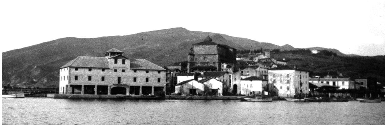
Fig. 3.327: Vista general del núcleo de Orio: cofradía de pescadores en primer plano. (AFO ORIO0176)
