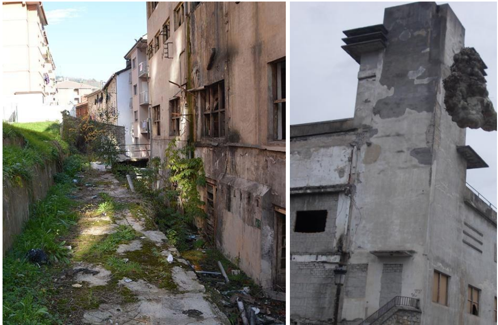
Fig. 3.89: Trasera de la fábrica y exterior de la torre. 2016. (Elaboración propia)
