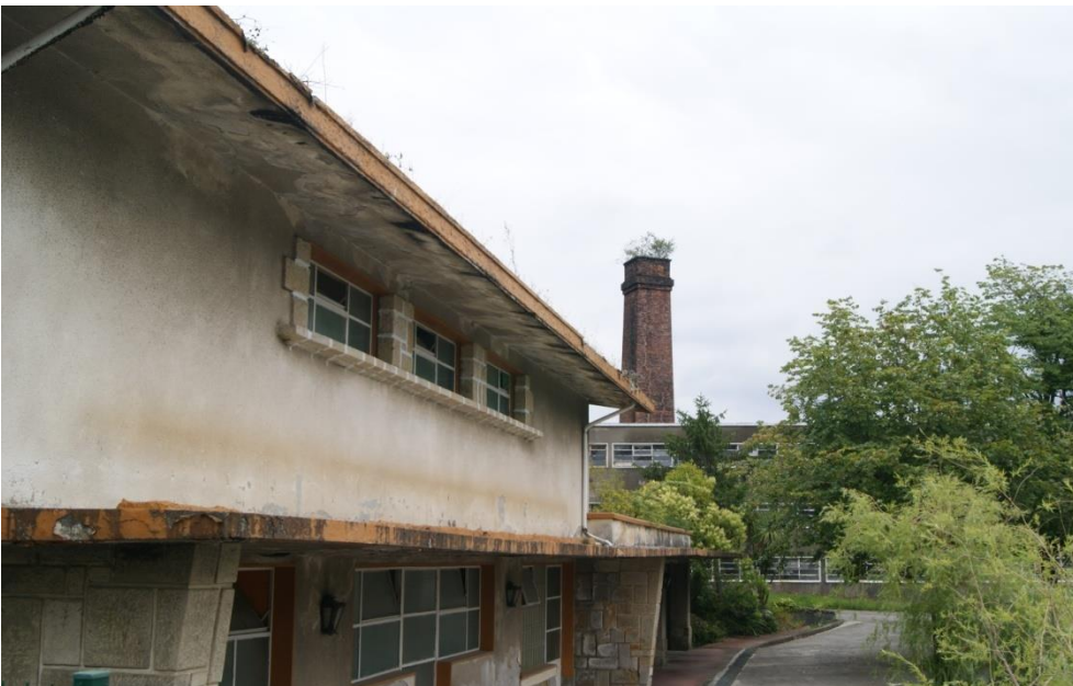
Fig. 3.348: Imágenes del exterior del edificio de laboratorio y portería. (Elaboración propia)
