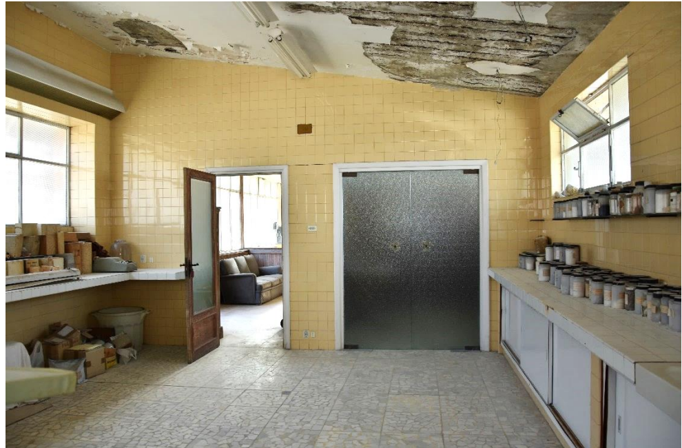
Fig. 3.376: Interior del edificio de portería y laboratorio. (Javier Pérez)
