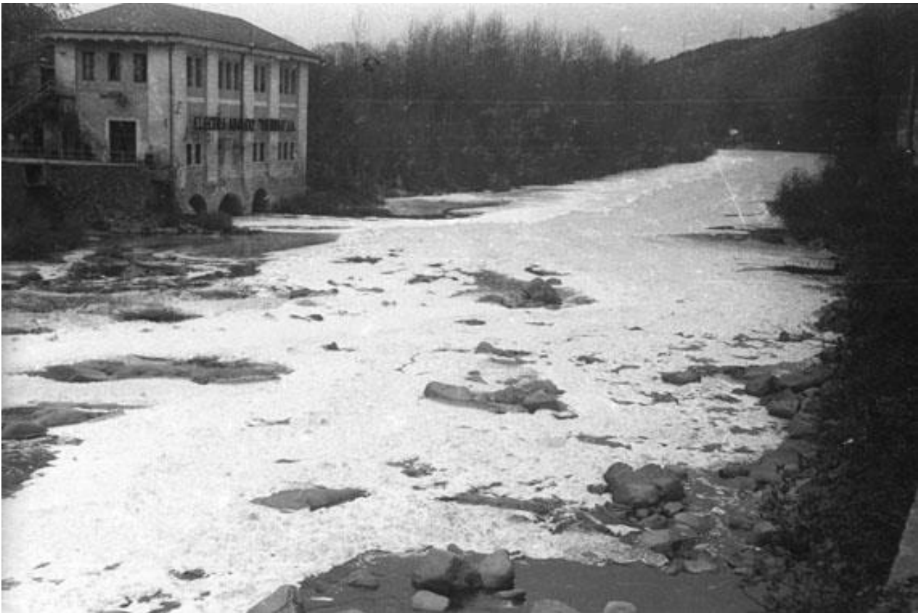
Fig. 3.296: Imagen de la central, 1962. (GureGipuzkoa)
