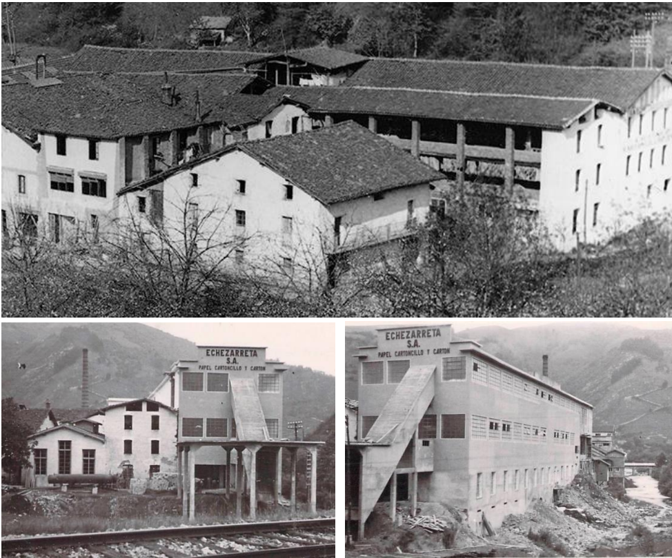
Fig. 3.392: Diferentes aplicaciones de la fábrica de pisos en Echezarreta. (Ayto. Legorreta; AEPE F 570;571)
