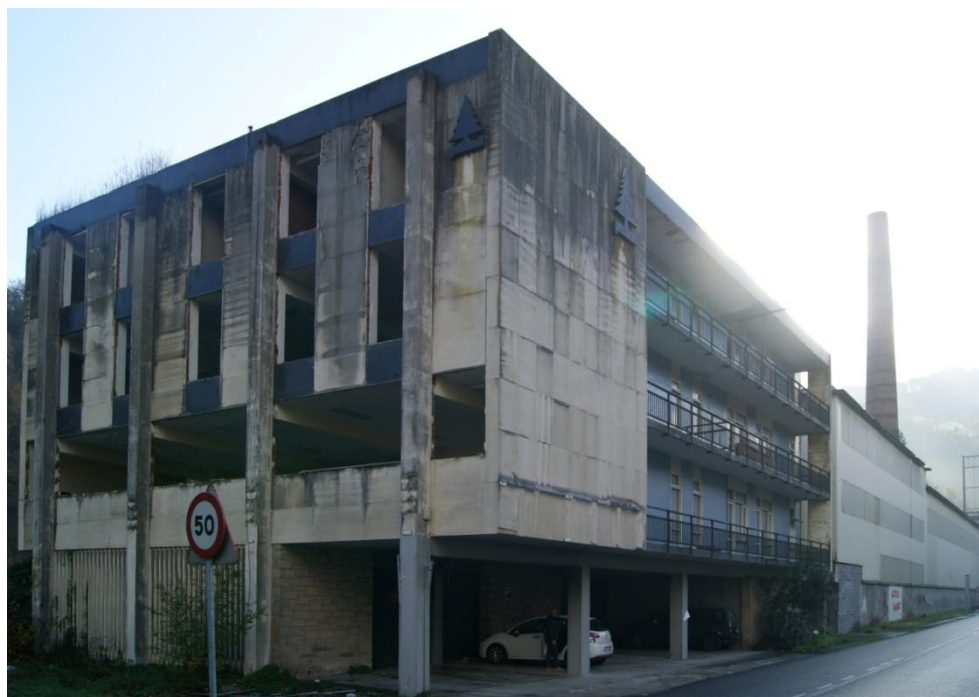
Fig. 3.194: Exterior del edificio de vivienda y oficinas en 2015. (Elaboración propia)
