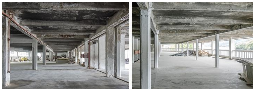
Fig. 3.343: Interior de la nave: estructura nueva de la Zona D (izqda.) y estructura preexistente diseñada por Astiazaran, con la cubierta sustituida (dcha.). (Elaboración propia)
