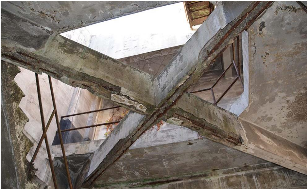
Fig. 3. 86: Estructura interior de la torre. 2016. (Elaboración propia)
