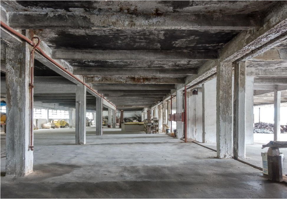
Fig. 3.383: Primera crujía (sur) de la zona C en segunda planta, bajo la cubierta. (Ana Vitoria)
