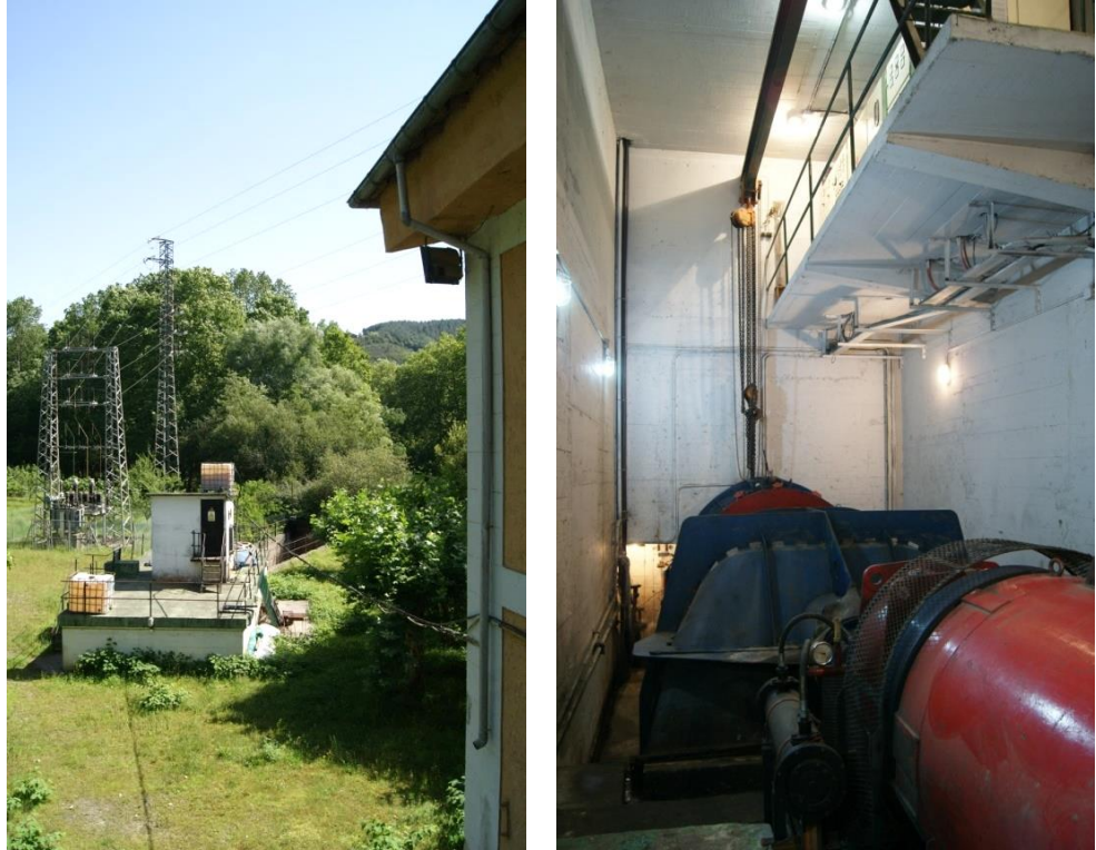
Fig. 3.304: Imagen exterior e interior del nuevo edificio. (Elaboración propia)
