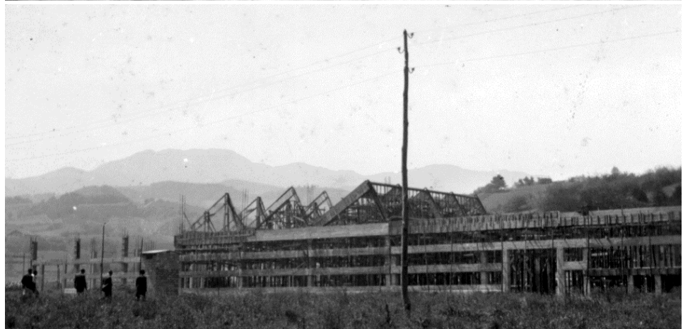
Fig. 3.229: Pabellón primitivo en construcción desde el lateral oeste. Se está construyendo la estructura de cubierta. (AMV)
