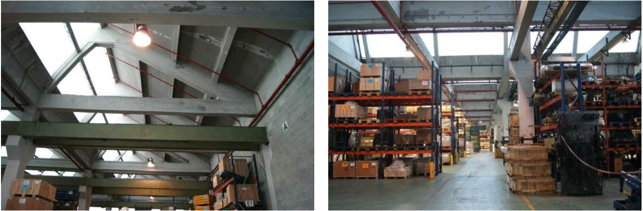
Fig. 3.239: Estructura de la cubierta dentada del pabellón primitivo desde el interior. (Elaboración propia)
