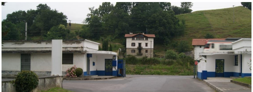
Fig. 3.243: Edificios auxiliares desde el interior de la parcela. (Elaboración propia)
