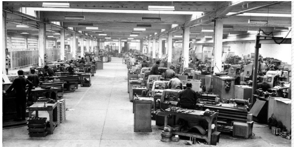
Fig. 3.272: Interior del pabellón nº 2: tornos de la zona de mecanizado. 1962. (AMV)
