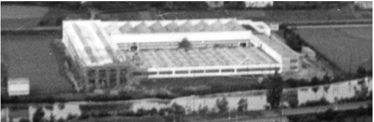
Fig. 3.253: Conjunto fabril en 1961 donde se observa el andamiaje frente al pabellón nº 3. (AMV)
