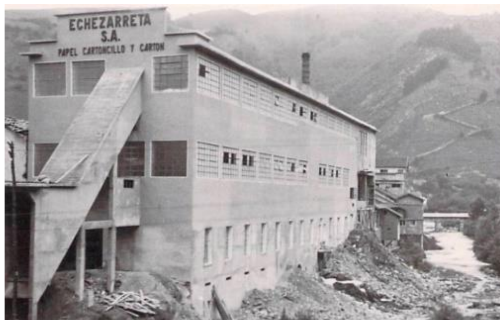
Fig. 3.122: El edificio para la producción de pasta química recién construido. (AEPE F 570)
