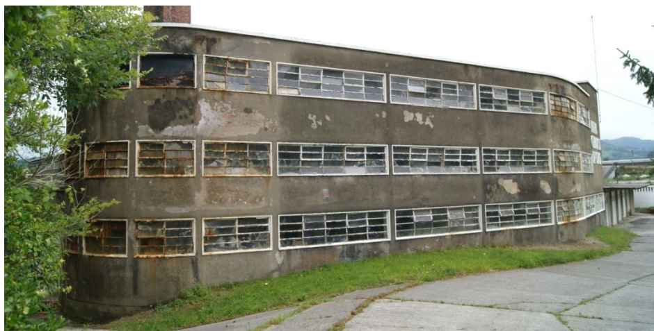
Fig. 3.378: Imagen general de la parte norte de la fachada oeste. (Elaboración propia)
