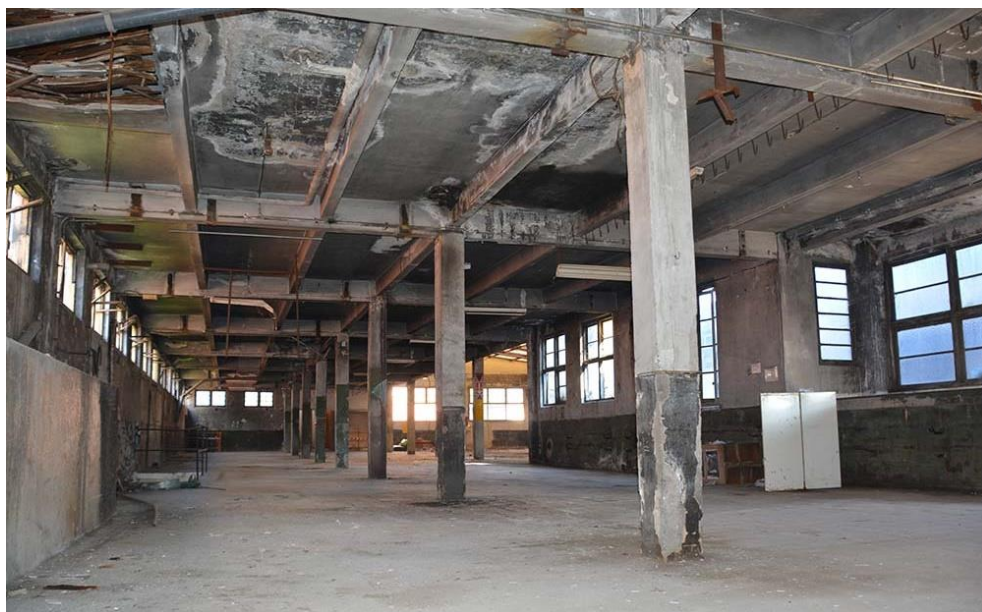
Fig. 3.82: Interior de la fábrica: planta segunda. 2016. (Elaboración propia)
