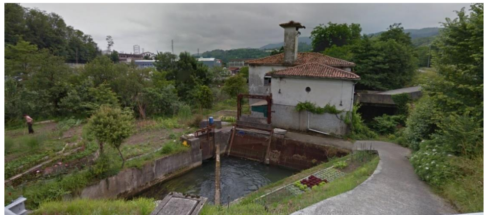
Fig. 3.291: Molino de Agaraitz convertido en central hidroeléctrica. (GoogleMaps: Street view)
