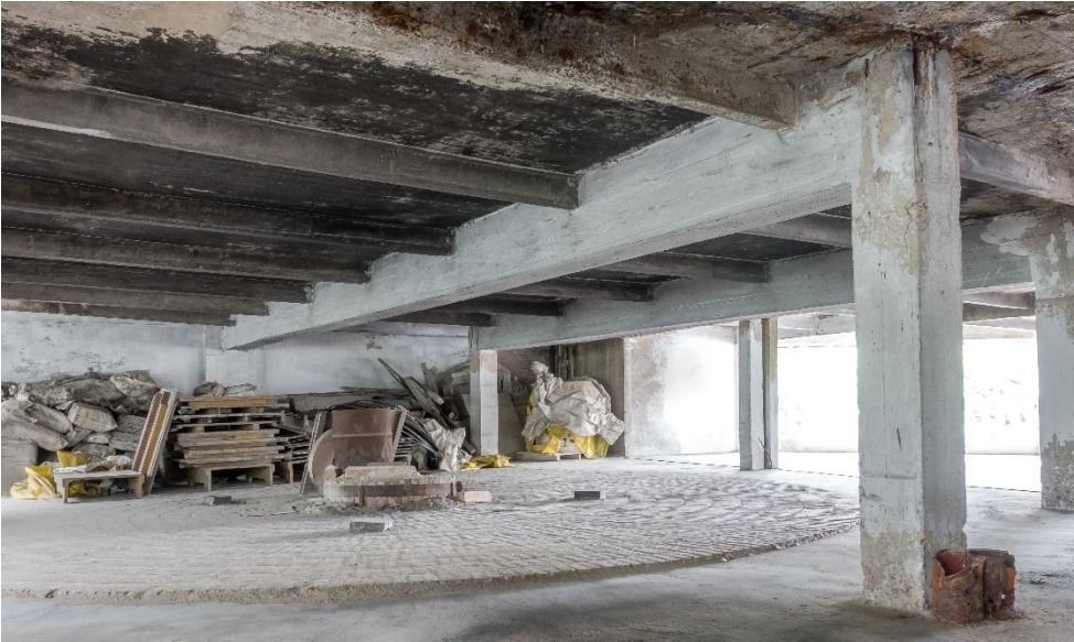
Fig. 3.365: Parte superior del horno 4 en planta segunda. (Ana Vitoria)
