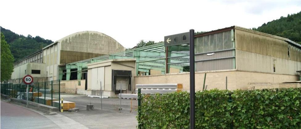
Fig. 3.183: Estado del pabellón de talleres y almacén en 2017. (Elaboración propia)
