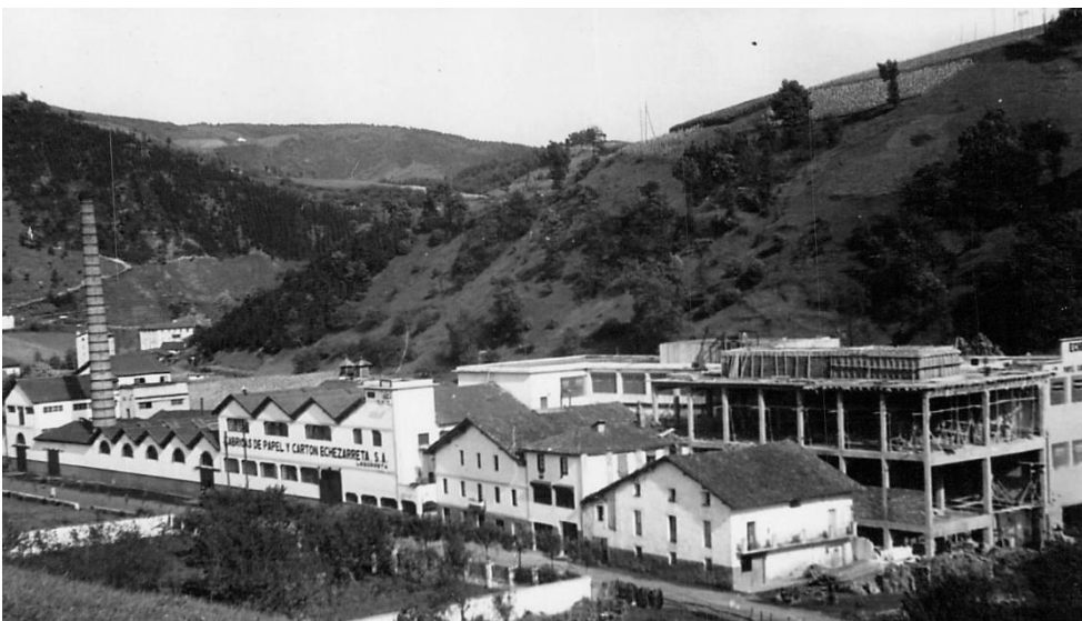
Fig. 3.125: El conjunto fabril en octubre de 1951. El edificio para pasta mecánica en construcción. (AEPE F 501)
