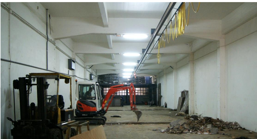
Fig. 3.280: Interior del espacio (PB) que estuvo ocupado por la DFG. 2016. (Elaboración propia)
