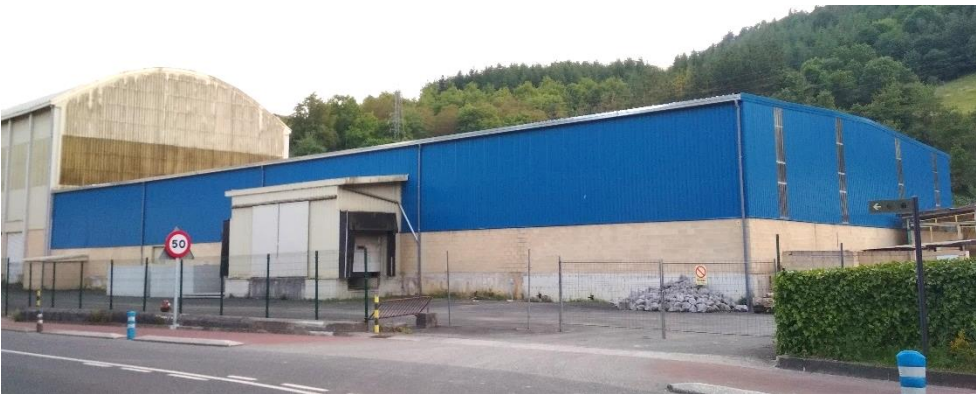
Fig. 3.184: Estado del pabellón de talleres y almacén renovado en 2018. (Elaboración propia)
