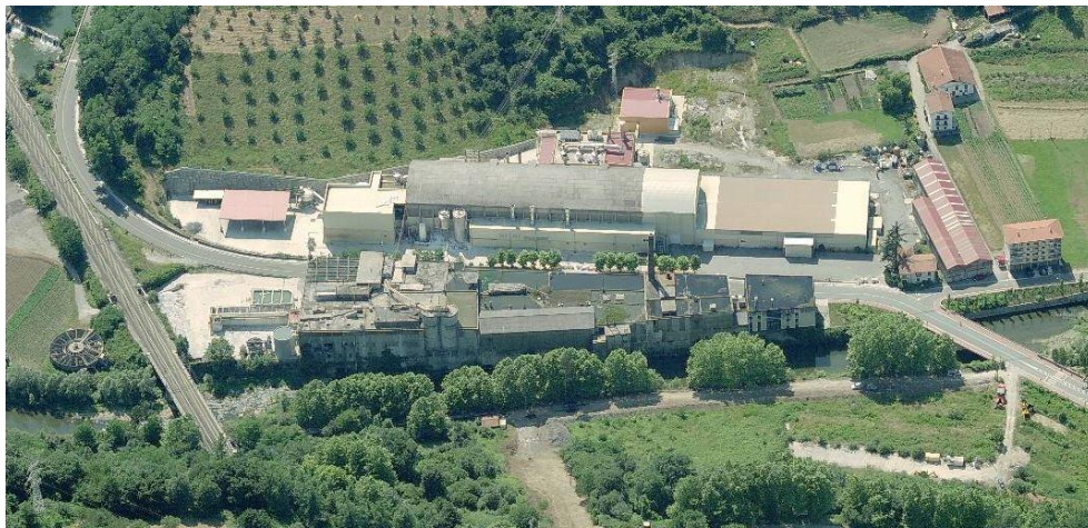
Fig. 3.154: Vista del conjunto fabril desde el este. 2017. (b5m.gipuzkoa.eus)
