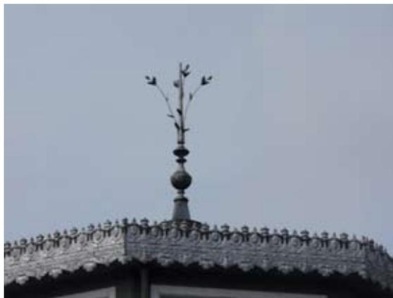
Fig. 9) Crestería del alero y remate de la cúspide del tejado.
