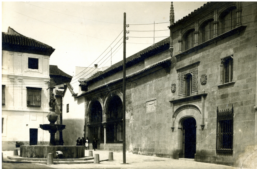
Fig. 6: Vista de la fachada del Museo Provincial de Bellas Artes tras la finalización de las obras de reconstrucción, acceso y complemento de la fachada realizadas por Francisco Javier Luque, ca. 1932. AHPCO. FFRT. F2285. Colección de la Junta de Andalucía.
