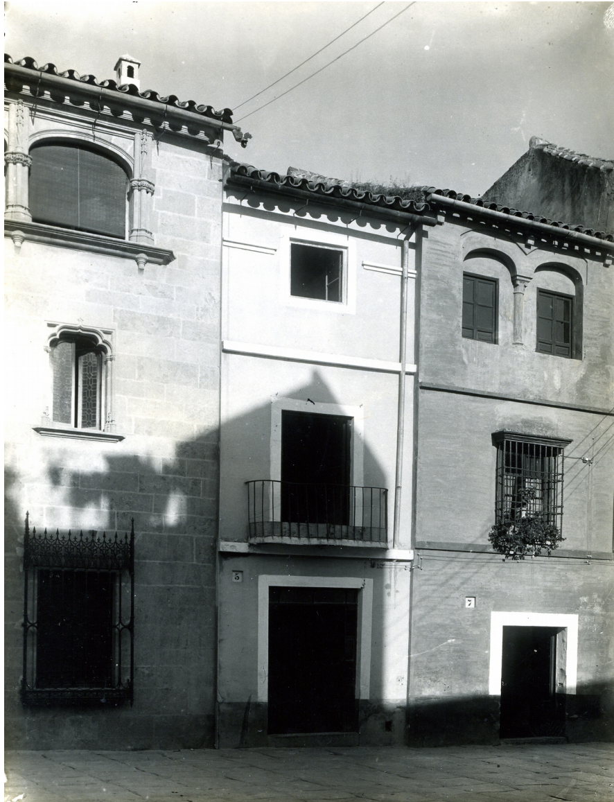
Fig. 7: Detalle del lado este de la plaza del Potro con la fachada de la casa número 5 contigua al Museo sin intervenir. ca. 1934. AHPCO. FFRT. F2282. Colección de la Junta de Andalucía.
