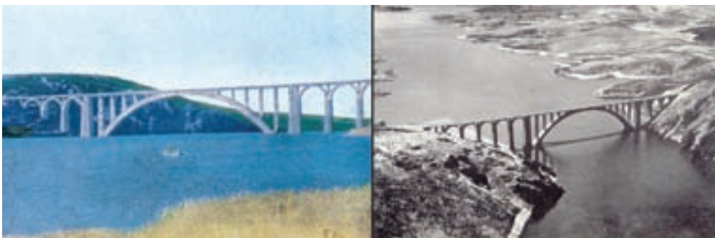
FIG. 22 Vistas libres del viaducto.
