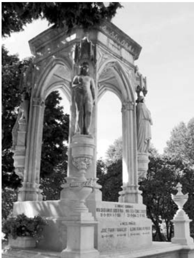
FIG. 3. Mausoléu de Adriano da Costa Ramalho no Cemitério de Agramonte (Porto), totalmente executado pela oficina de cantarias de António Almeida da Costa e com alegorias em pedra mármore modeladas na Fábrica de Cerâmica das Devesas.
