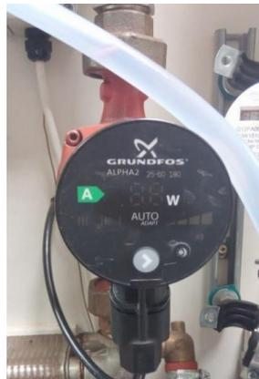
Fig. 101. Bomba del circuito caliente
