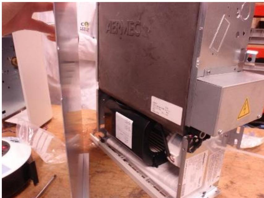
Fig. 181. Ventiloconvector Omnia UL 11P parcialmente desmontado, siendo visible el ventilador y su motor eléctrico.
