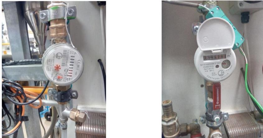
Fig. 103. Caudalímetro circuito frío (I) y circuito caliente (II)
