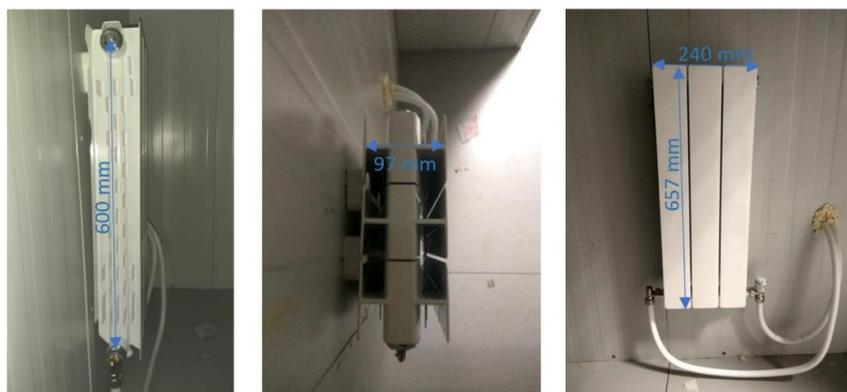
Fig. 228. Geometría del radiador de alta temperatura instalado en cámara frigorífica.
