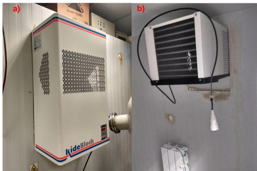
Fig. 224. a) vista exterior del equipo frigorífico y b) vista interior.
