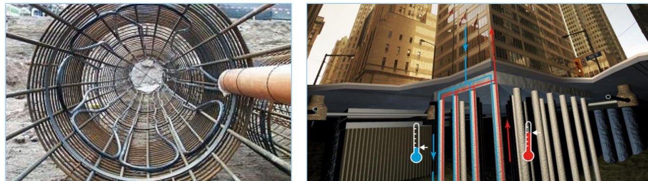
Imágenes del sistema experimental de geotermia mediante pilotes activos
