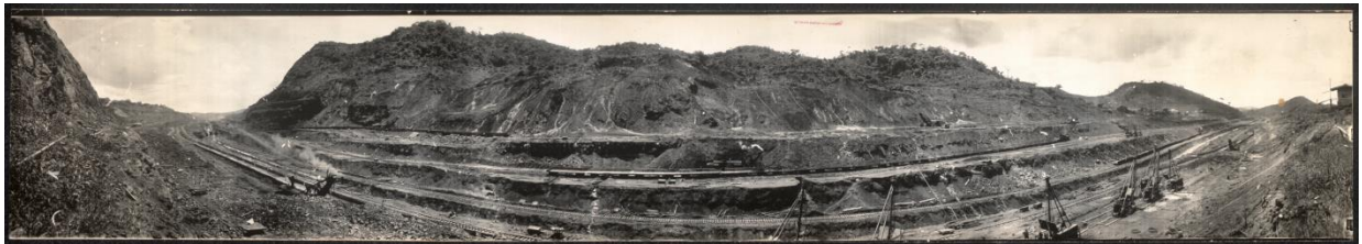
Ilustración 3: Excavaciones en Corte Culebra
