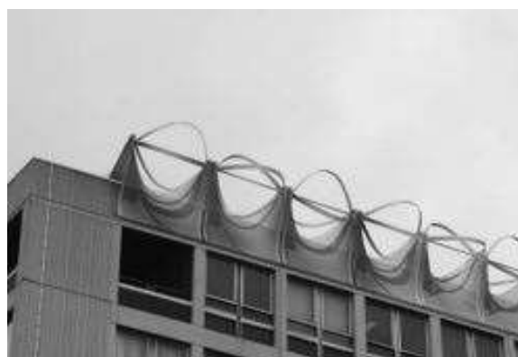
Irudia 3-7 eta 3-8. T. Sharpe eta P. Gordon-en turbinaren diseinua eta haren instalazioa eraikin baten goiko ertzan
