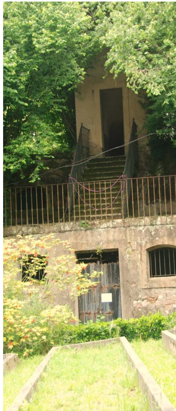
Ilustración 87_ Acceso al depósito Buscando y debajo el acceso a la maquinaria de dicho depósito. Años más tarde restaurarían la puerta y ventanas de la sala que se ve en la parte inferior. (Miguel Cavero)
