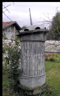
Ur-biltegiaren aireztapen latorrizko tximinia. Chimenea de hojalata para ventilación del Depósito.
