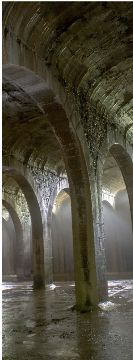
Ilustración 67_ Fotografía del depósito Buskando, Ulia (Miguel Caverro)
