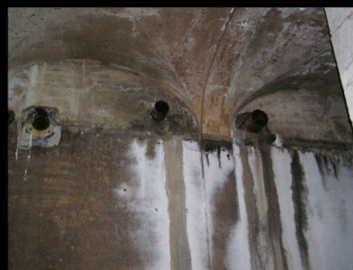
Harlangaitz hidraulikoaz luzitutako inguru-hormak eta ur-biltegia betetzeko urezko sarrerak. Muros perimetrales de mampostería hidráulica enlucida y bocas de alimentación de agua para llenado del Depósito
