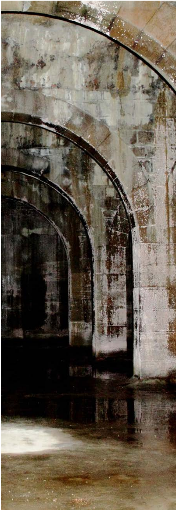
Ilustración 7_ Arcos del depósito de agua Buskando (Asociación Vecinos Ulia)
