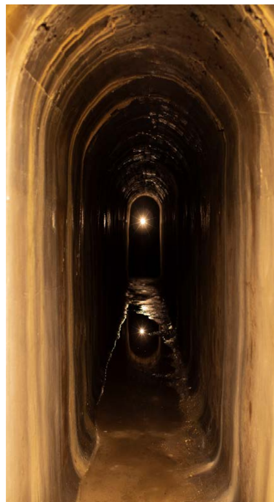
Ilustración 96_ Pasadizo que hay entre las dos naves del depósito Buskando (Miguel Cavero)
