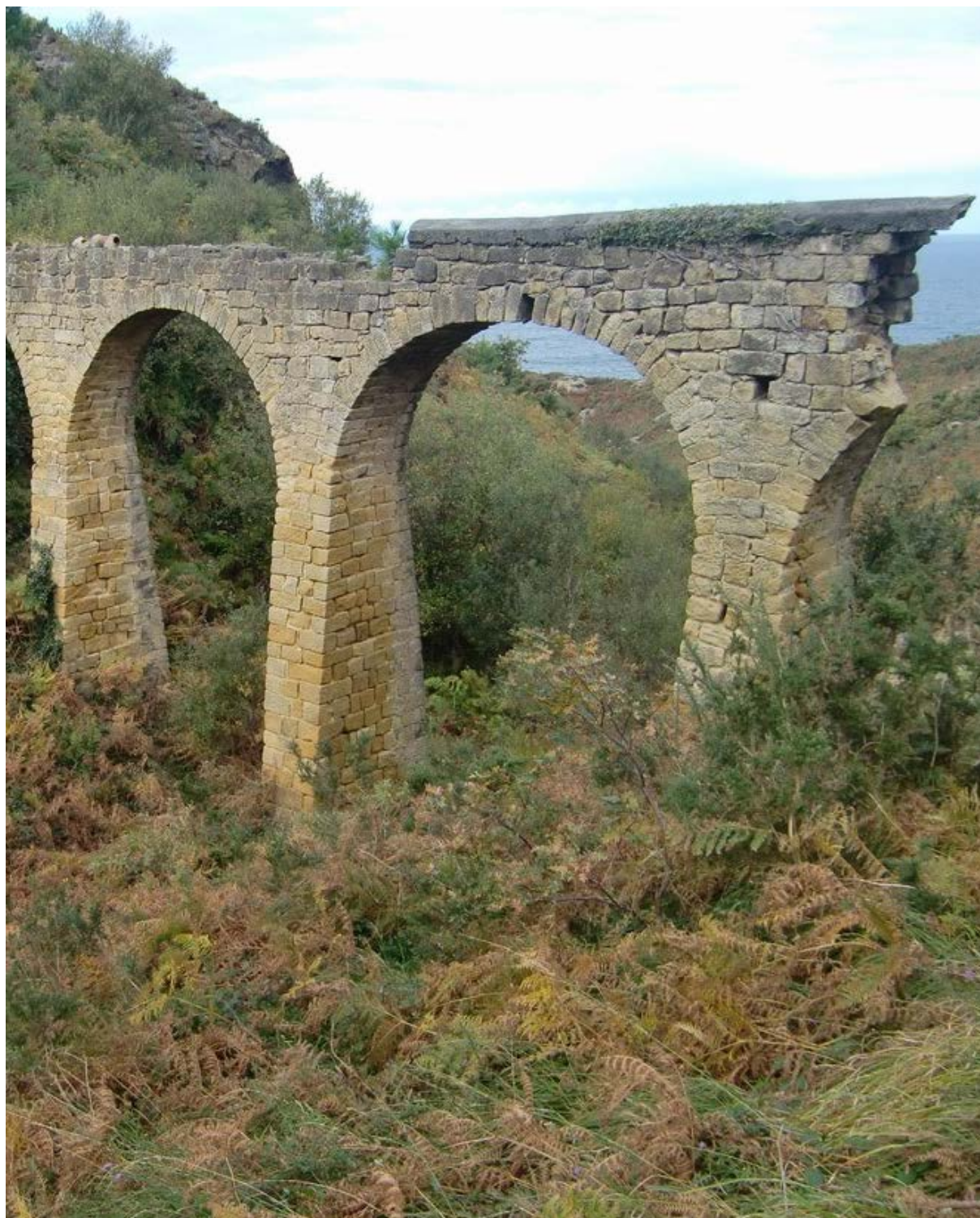
Ilustración 14_ Tramo del antiguo acueducto de Donostia, por donde llegaba el agua a los depósitos o al centro histórico (Wikiloc)
