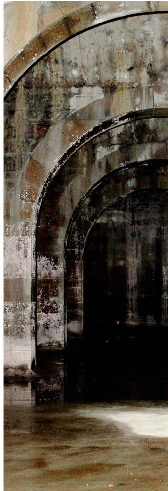
Ilustración 6_ Arcos del depósito de agua Buskando (Asociación Vecinos Ulia)
