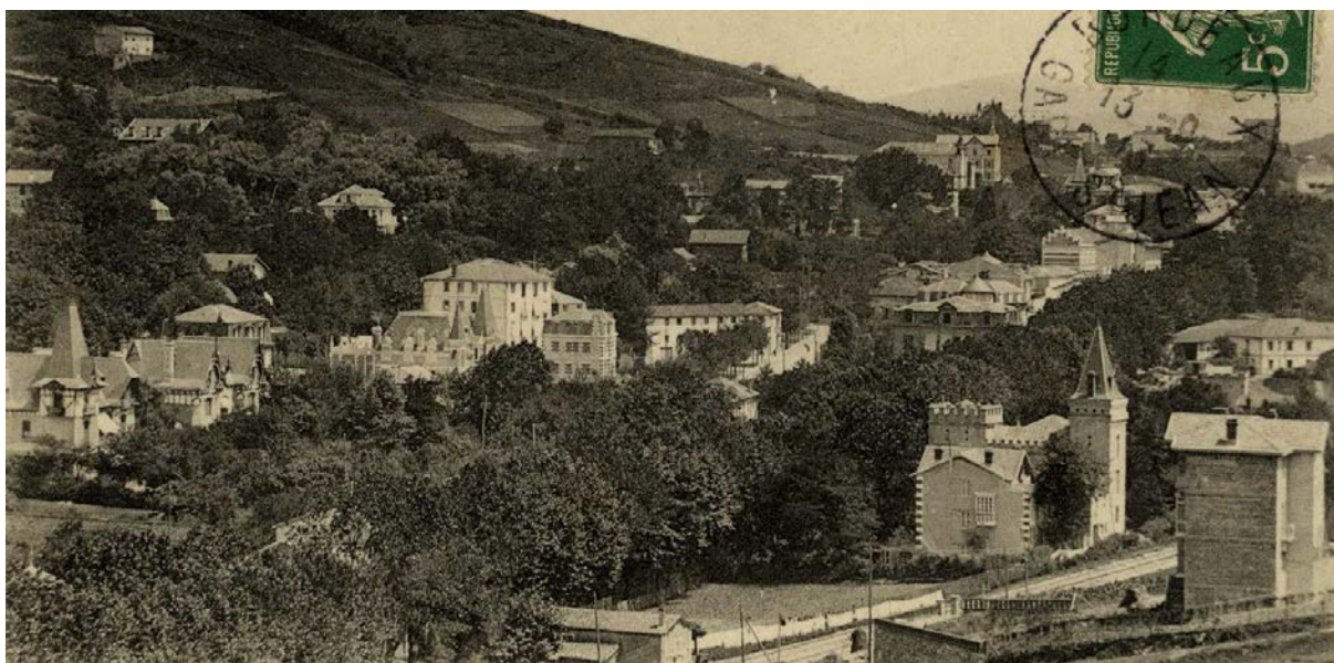
Ilustración 38_ Ategorrieta vista general (Gure Gipuzkoa)
