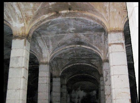
Ur-biltegiaren barruko hormigoizko arkuak eta gangak. Harearriko zutabeak. Arcos y bóvedas de hormigón del interior del Depósito. Postes de piedra arenisca.
