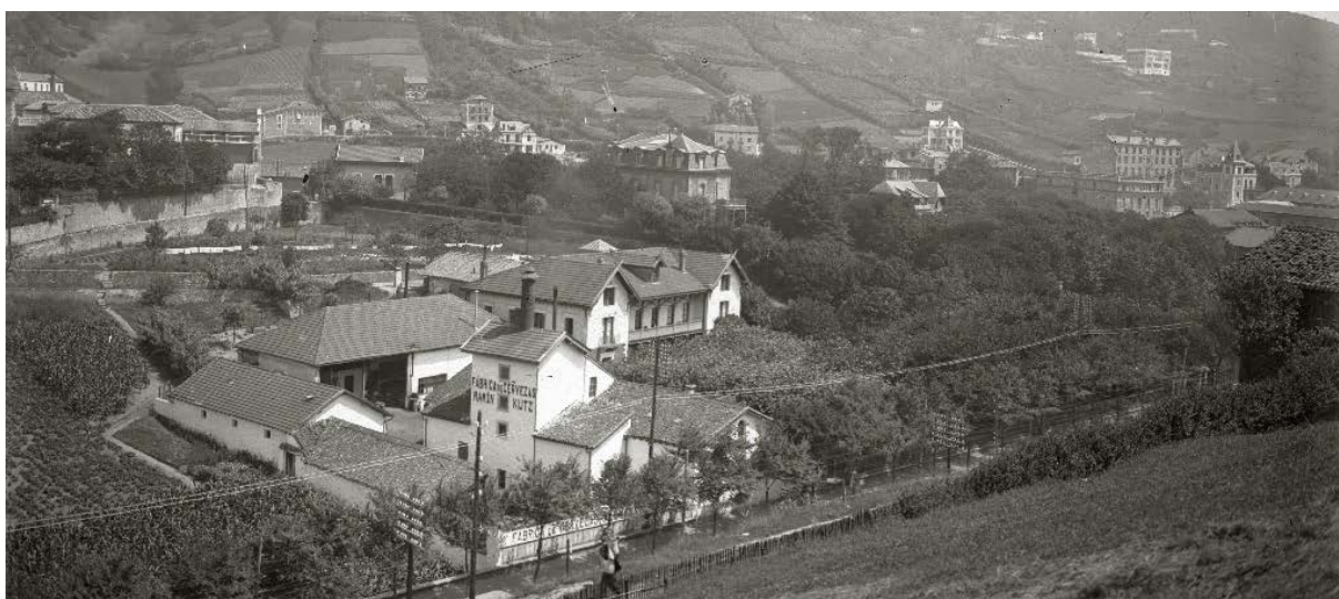
Ilustración 40_ Alto de Miracruz, vista desde el lado ferroviario (Gure Gipuzkoa)
