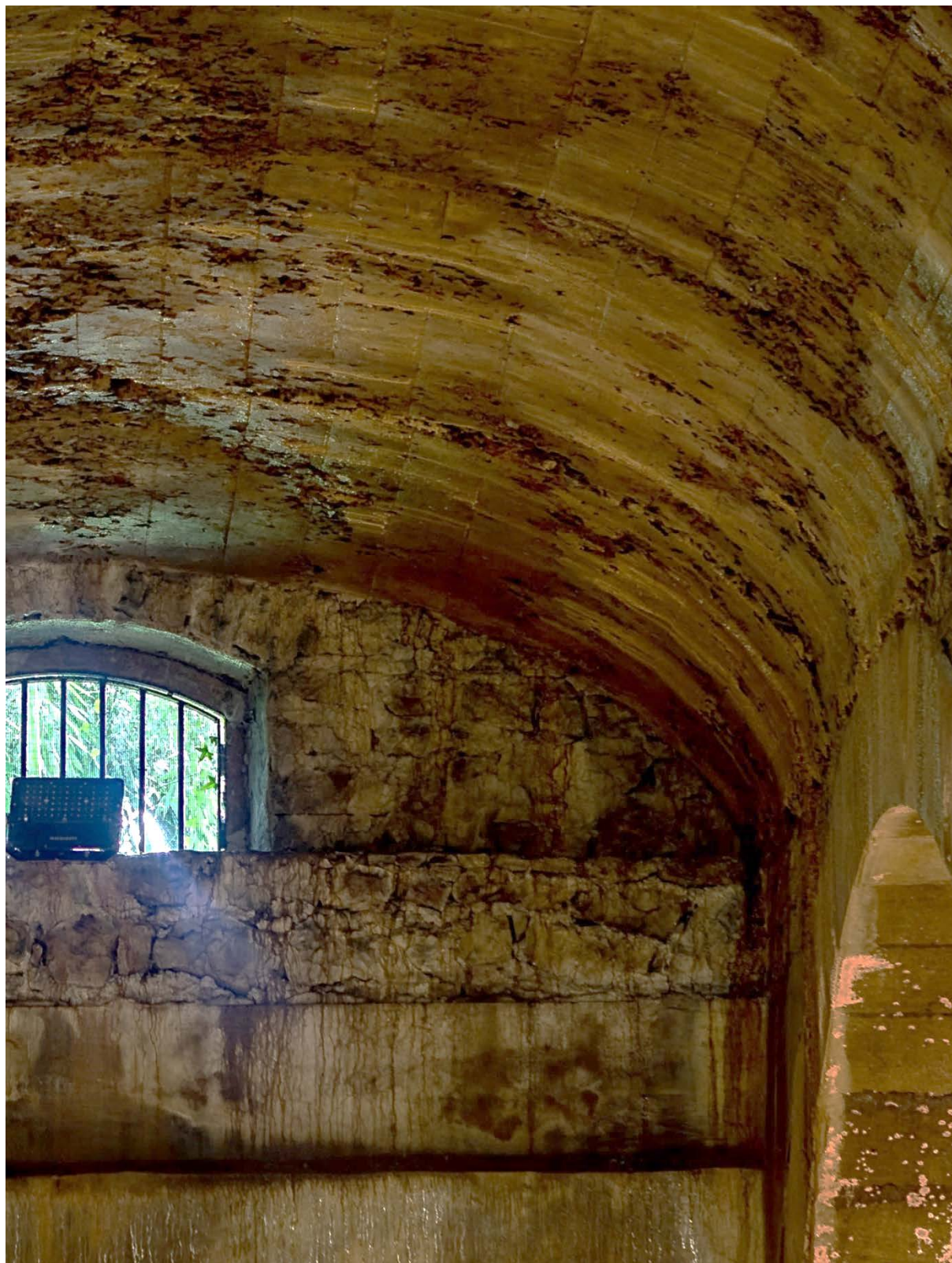
Ilustración 64_ Ventilación y entrada de luz del depósito Buskando, Uliá (Miguel Cavero)
