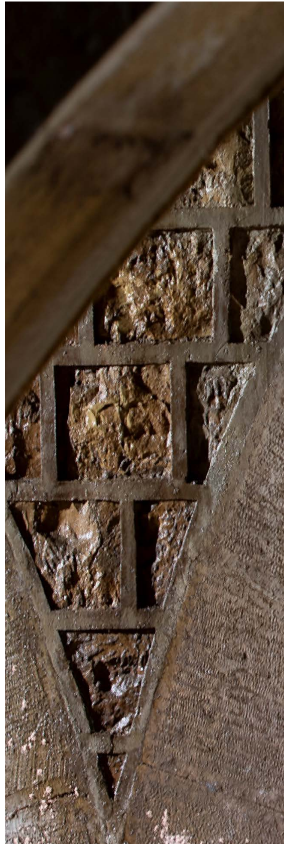
Ilustración 86_ Detalle de los arcos del depósito Buskando, Ulia (Miguel Cavero)
