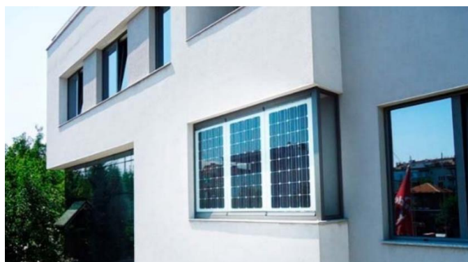
8. Imagen: Integración fotovoltaica en ventanas. Fuente: [25]
