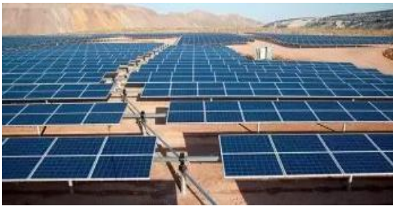
Figura 6: Planta FOTOVOLTAICA (Energía Solar)
