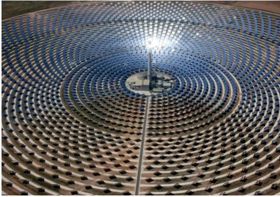
Figura 8: Planta termo solar de concentración (Noticias de la Ciencia y la Tecnología (NCYT), 2019)
