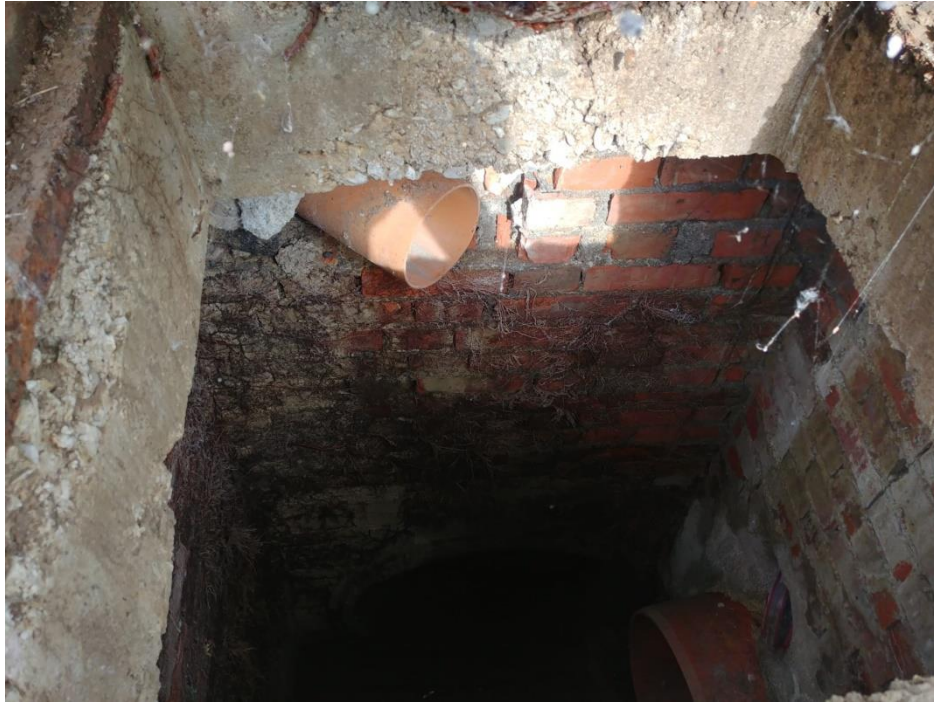
Irudia 14: Drainatze-sistemaren hodien irudia landa-azterketan
