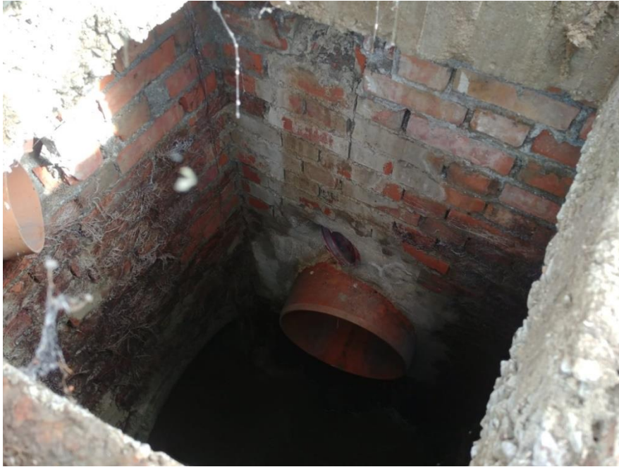
Irudia 10: Drainatze-sistemaren hodian irudia landa-azterketan
