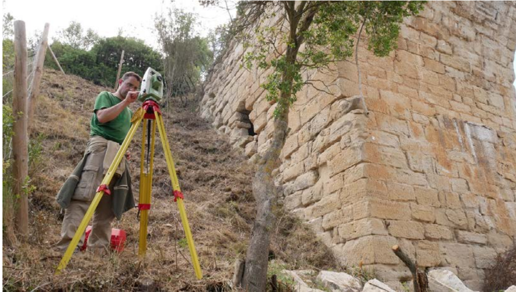
Fig. 10.- Medida de las coordenadas tridimensionales de las dianas utilizando una estación total topográfica.
