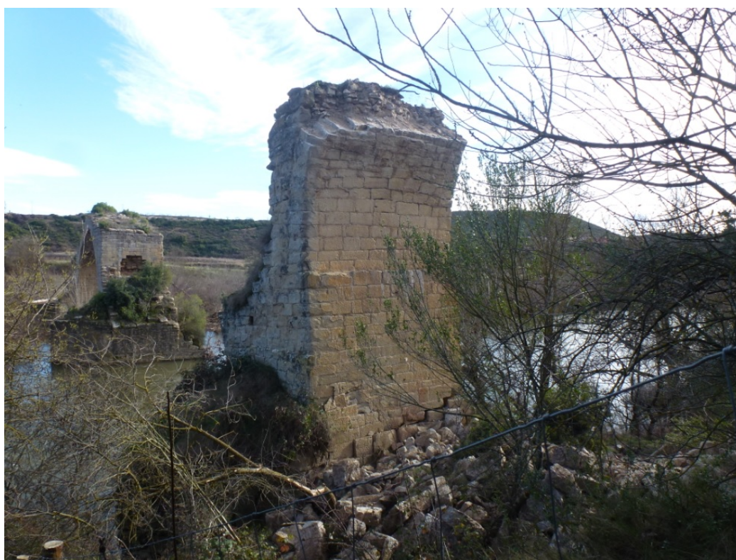
Fig. 5.- Imagen del pilar del arco 1 tomada el 31 de enero de 2021, cinco días después del colapso.
