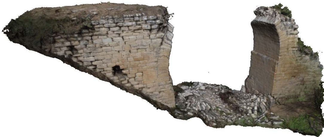
Fig. 13.- Vista perspectiva del modelo 3D de superficies correspondiente a los restos del arco y derrumbe, con texturas fotográficas ya aplicadas.
