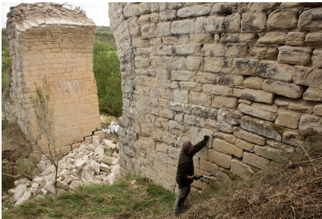
Fig. 9.- Preseñalización de la zona a modelar utilizando dianas de puntería de 4x4 cm.
