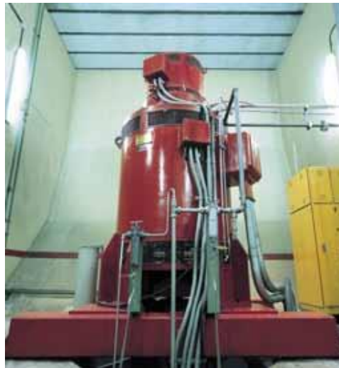
Figura 38. Turbina Kaplan de la central Virgen de las Viñas. Fuente: IDAE
