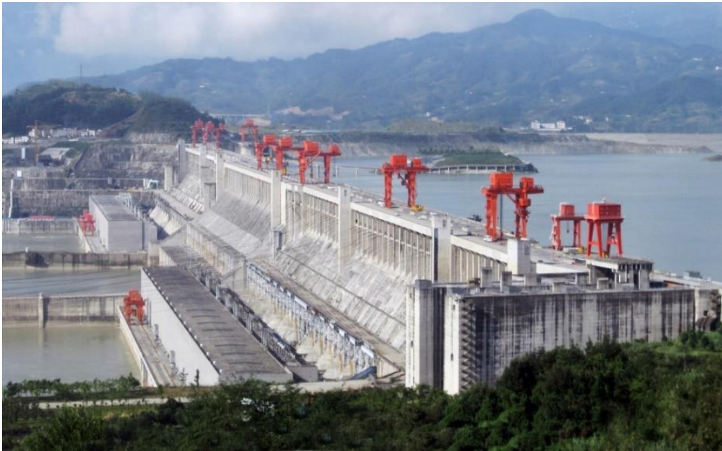
Figura 3. Central hidroeléctrica de la presa de las Tres Gargantas en China. Fuente: iAqua.
