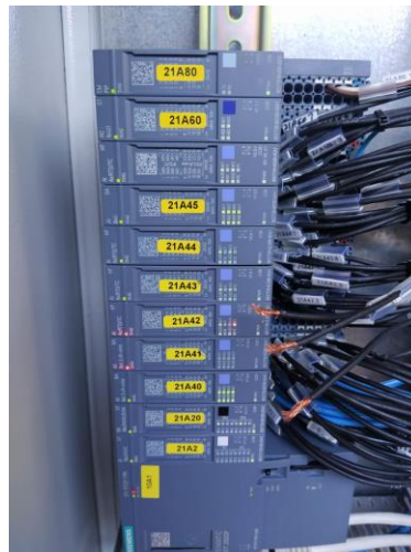
Figura 17 Fallo en el módulo de Siemens. Módulo con el piloto rojo encendido.
