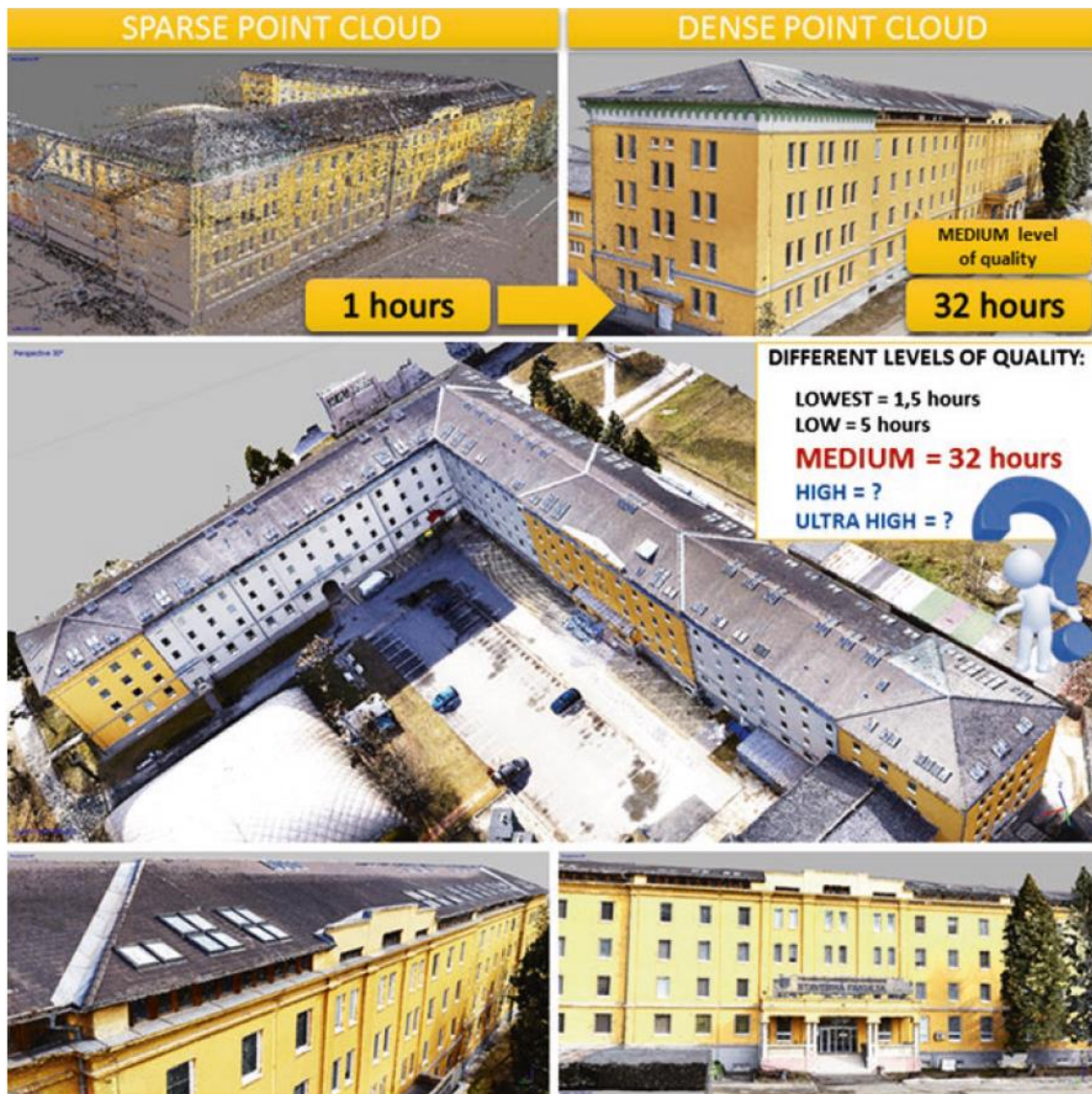
Figura 75. Calidad final de la nube de puntos de la fachada del edificio
