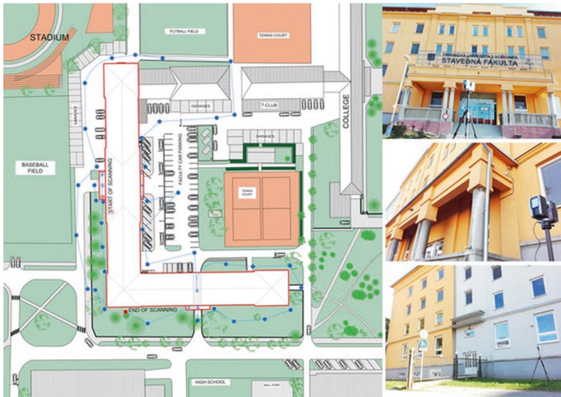
Figura 69. Proceso escaneo láser terrestre de la fachada del edificio
