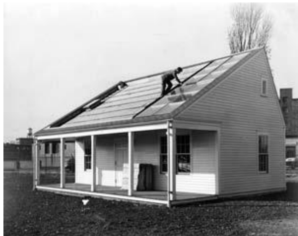
Figure 3. MIT Solar House I, first-ever BI solar prototype (MIT Solar Decathlon Team, n.d.).
