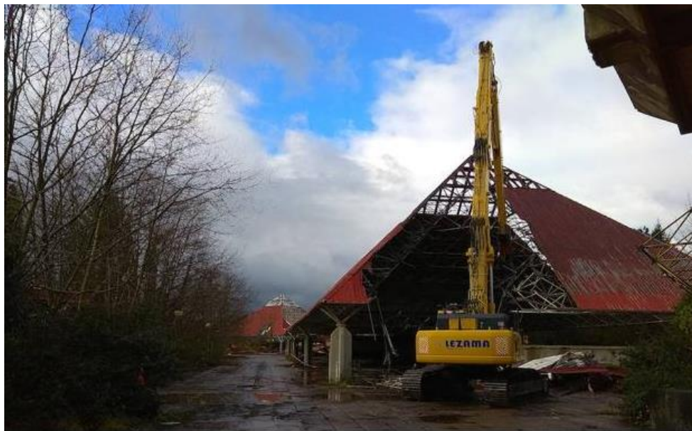
Ilustración 2: Deconstrucción de las instalaciones del Parque de Atracciones de Artxanda, Bilbao [13].
