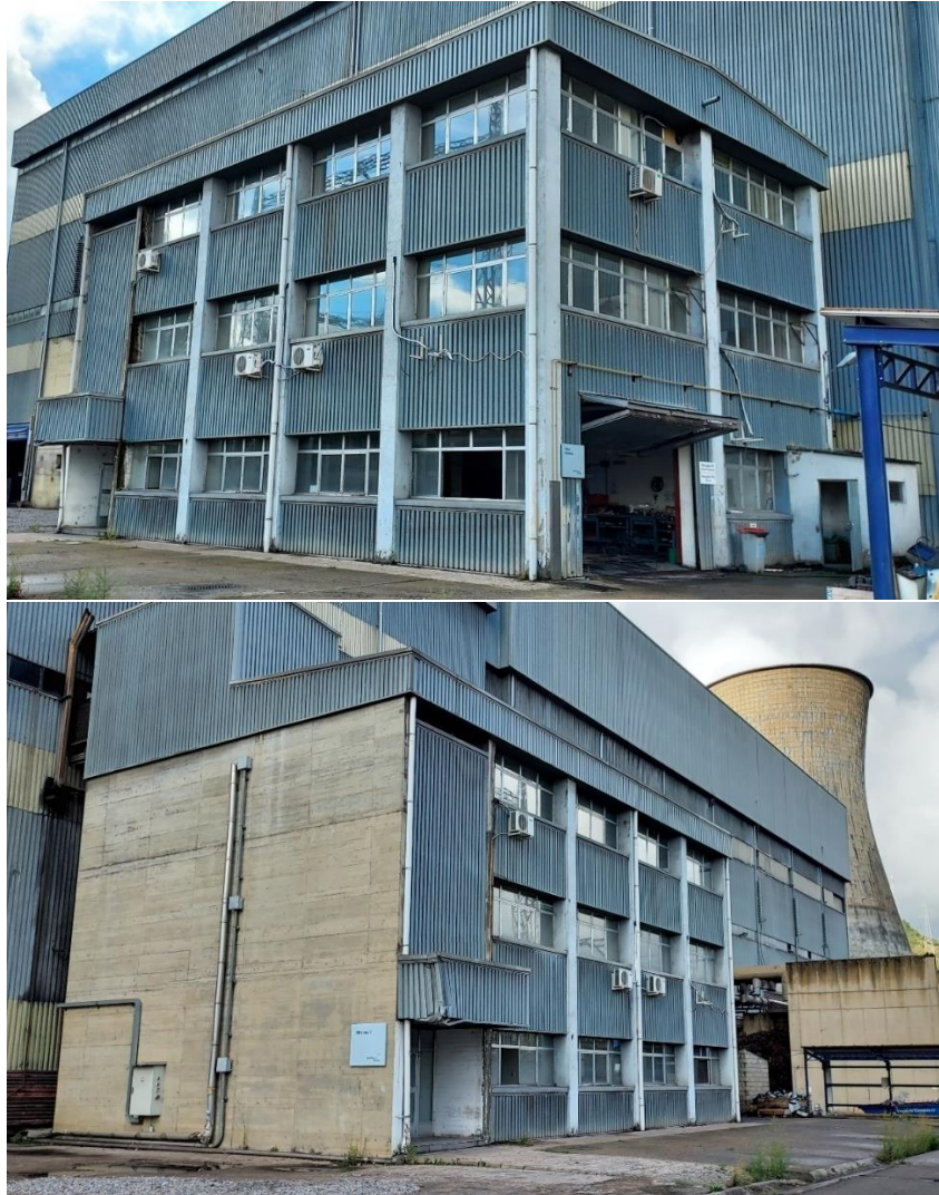
Ilustración 10: Edificio de tipología semi-industrial utilizado como caso de estudio.
