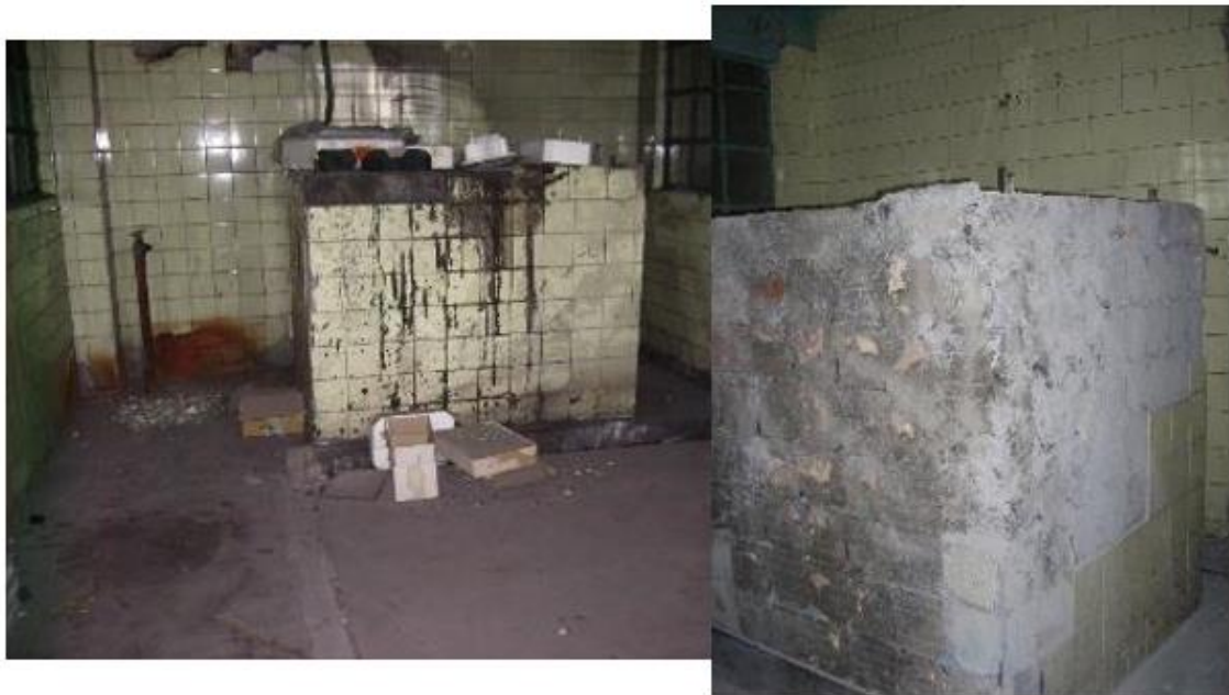
Ilustración 4: Repicado de azulejos contaminados para evitar la contaminación de la fracción pétreo tras la demolición [14].
