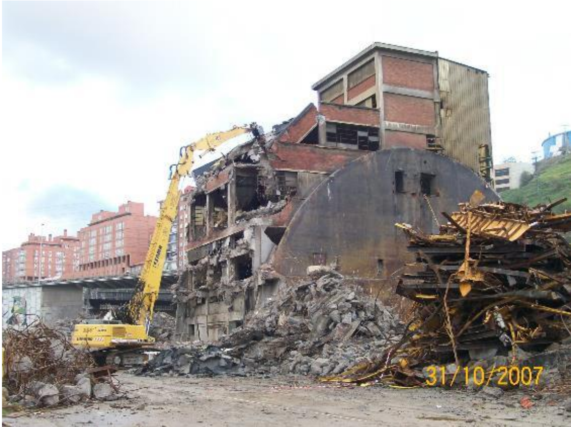
Ilustración 5: Demolición selectiva de cerramientos y estructuras, segregación en origen [14].
