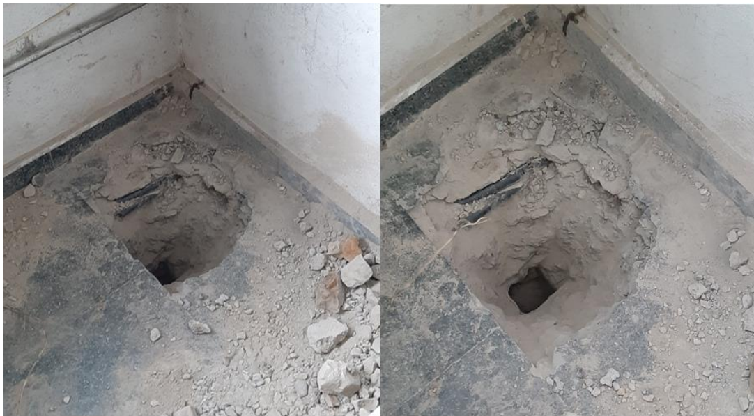
Ilustración 19: Cata realizada para la comprobación del espesor del forjado de la planta baja. Se obtiene que este es de 400mm
