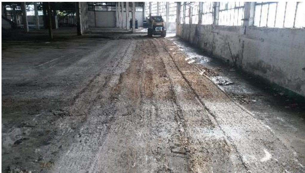
Ilustración 3: Limpieza de elementos contaminados. Fresado de suelos [14].
