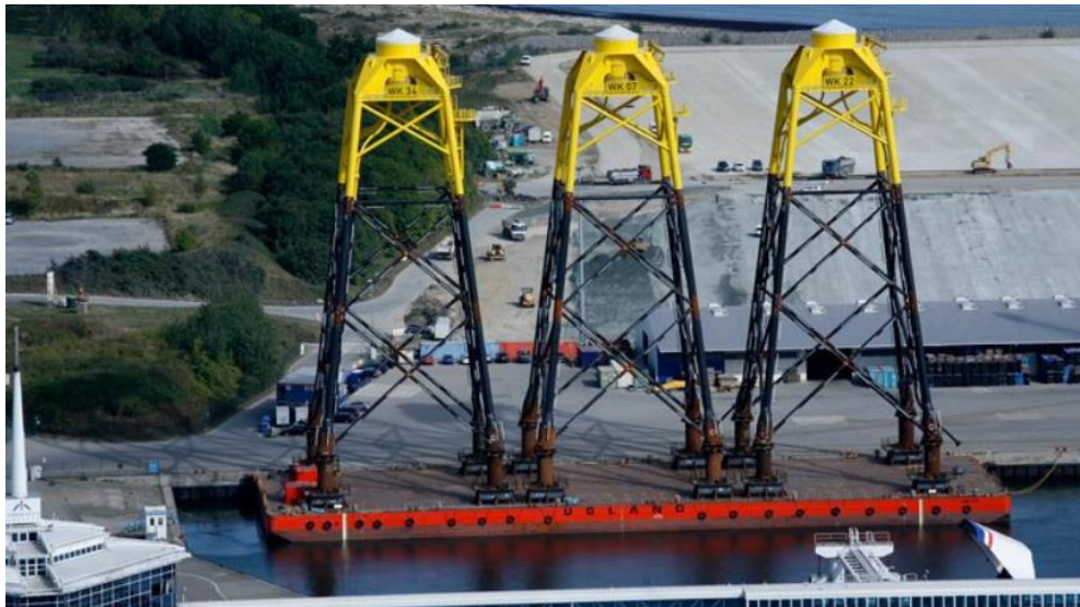
Ilustración 18. Subestructura Jacket real
