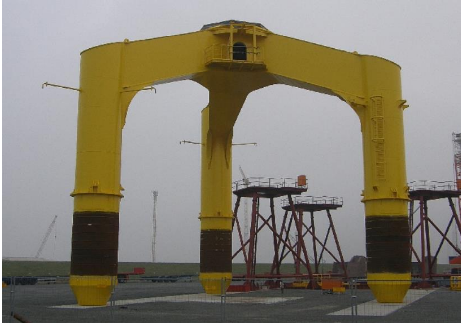
Ilustración 15. Subestructura tripilar real
