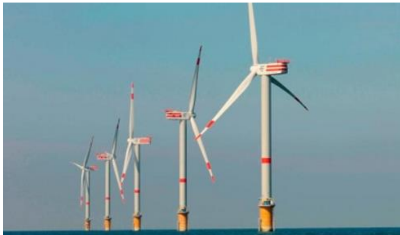
Ilustración 12. Subestructura monopilar real
