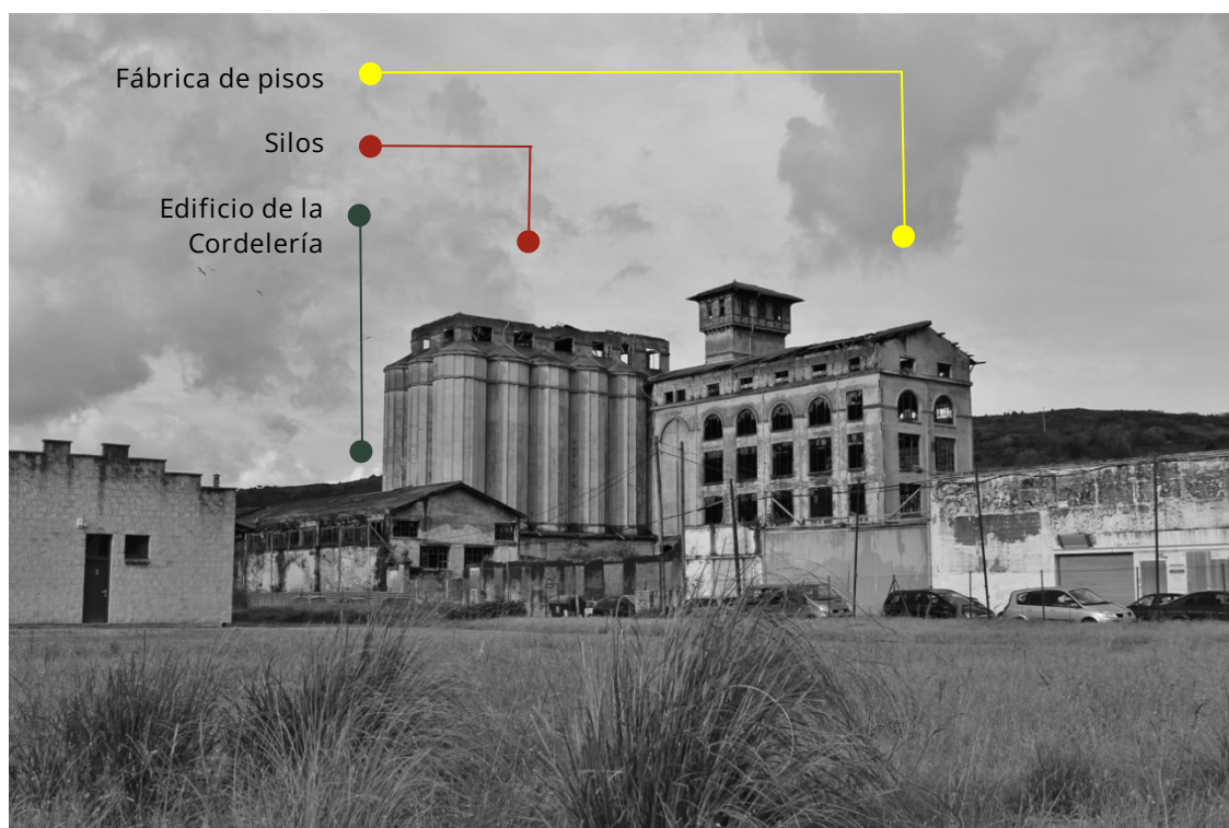
Figura 528. Fotografía que muestra las diferentes edificaciones que componen lo que queda del complejo de GRANDES MOLINOS VASCOS.
