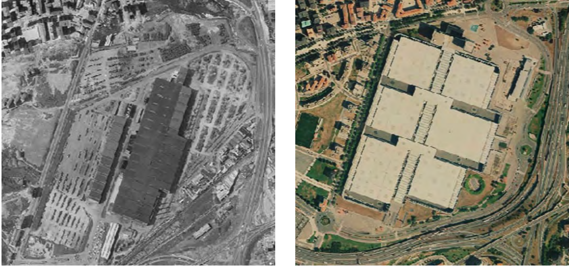
Figuras 296 y 297. Comparativa Ortofotográfica. En la imagen izquierda, de 1977, aparecen las edificaciones industriales que formaron parte del complejo de AHV; mientras que, en la imagen de la derecha, de 2019, aparece el mismo solar, ocupado hoy por el BEC.
