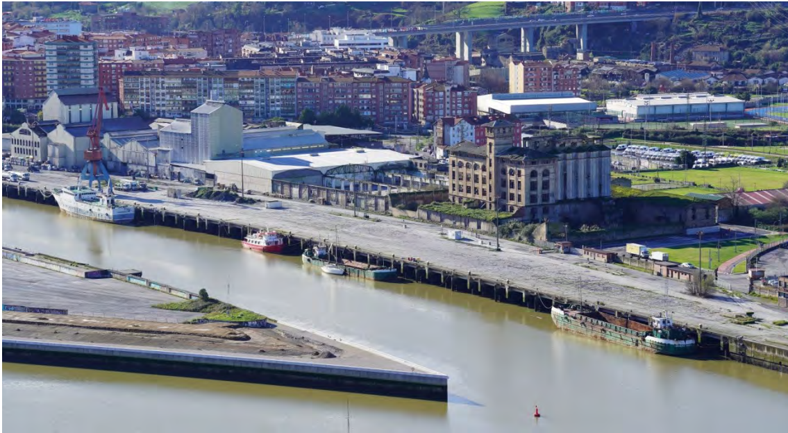
Figura 539. Fotografía de la harinera y el entorno industrial donde se ubica en la actualidad. En su reutilización, se considera fundamental conservar la relación directa de la edificación con la Ría.
