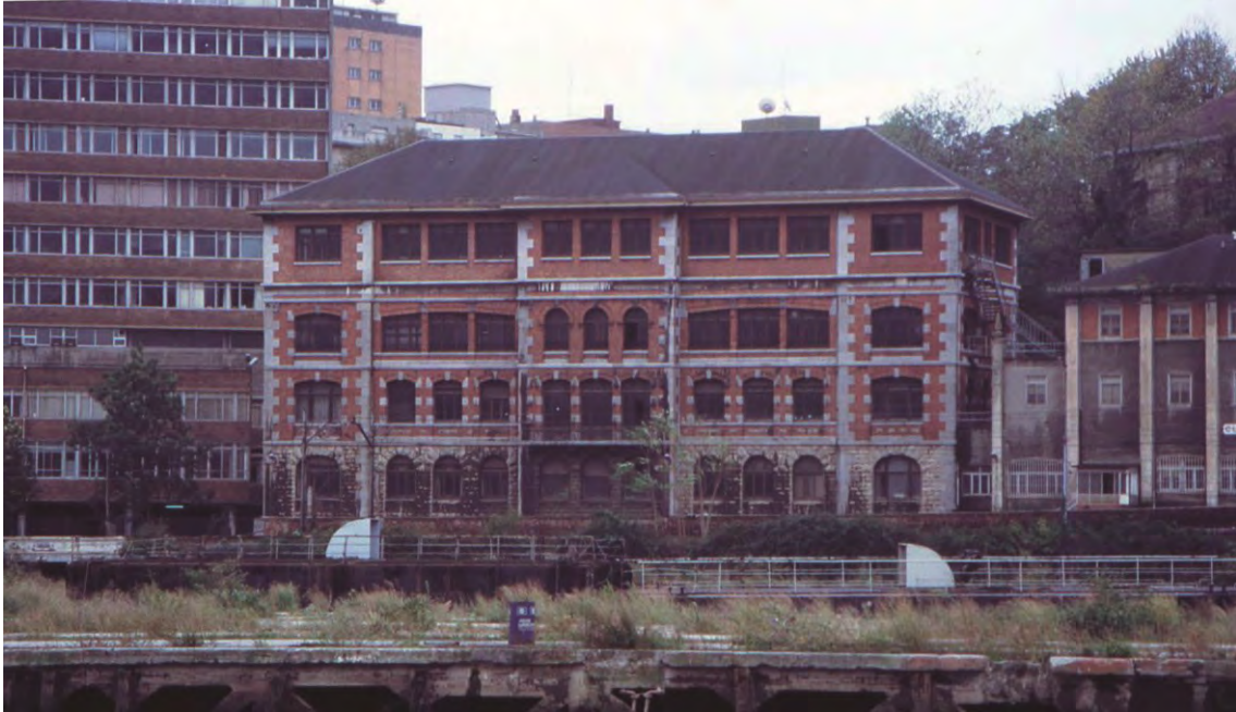
Figura 247. Fotografía del desaparecido edificio de oficinas del Astillero Euskalduna, demolido junto a la práctica totalidad del complejo en 1992, con financiación del PDRRII.
