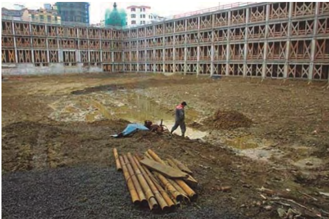
Figura 492. Fotografía del vaciado de la estructura interior de la ALHÓNDIGA MUNICIPAL DE BILBAO. En la fotografía se ve la conservación de la primera crujía perimetral del edificio original.
