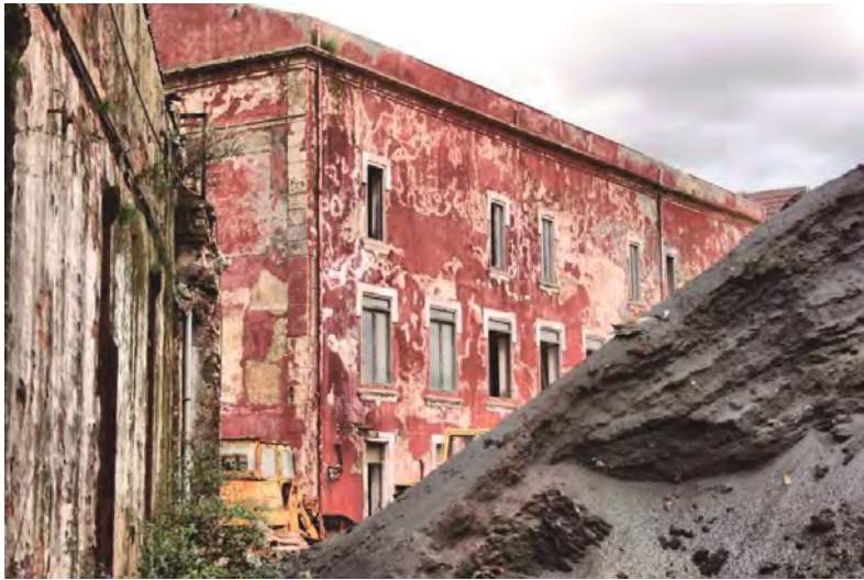
Figura 8. En la imagen izquierda se observa como la base un montículo de gran tamaño de material de construcción apoya en la pared de una de las naves protegidas de Talleres de Zorroza, invadiendo el área protegida (Fuente: AVPIOP).
