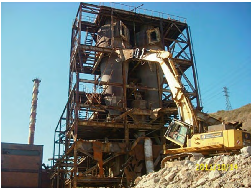
Figura 294. Fotografía de la demolición de las instalaciones de BEFESA en Lutxana.
