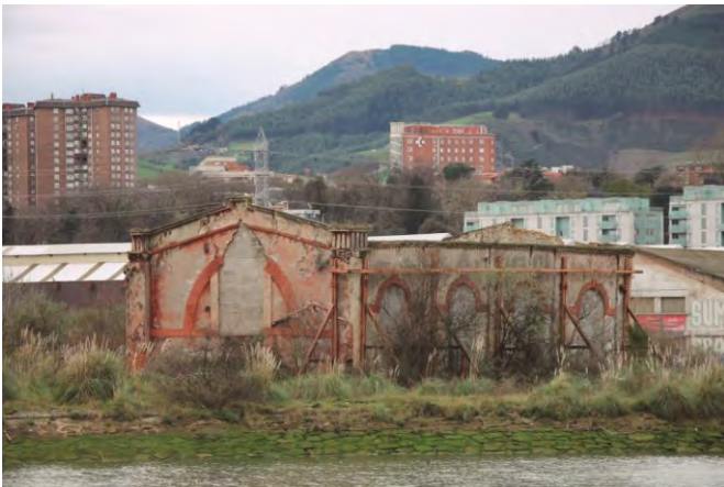
Imagen 17. Fotografía del pabellón de la Central de Fuerza. En la imagen se aprecia la pérdida de la cubierta y su estructura de sustentación, además de la degradación de los muros perimetrales del inmueble. En el lateral destacan los soportes metálicos que puso la DFB y que mantienen en pie la edificación.
