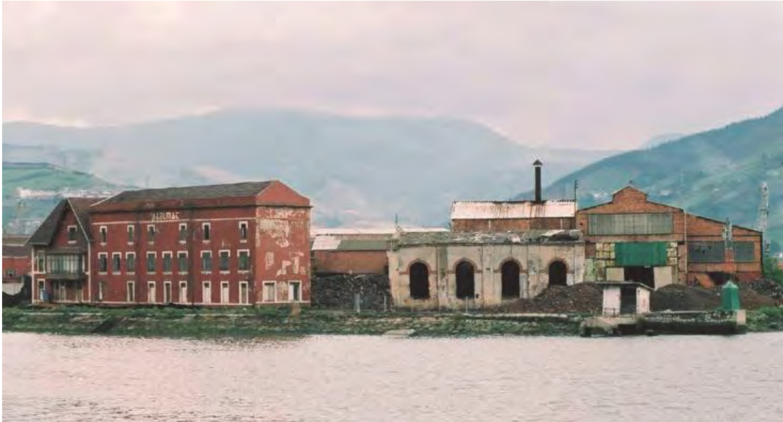
Figura 6. La imagen, extraída de la ficha nº 447 del Inventario de Patrimonio Cultural del País Vasco muestra el área protegida de los Talleres de Zorroza invadida por grandes acumulaciones de escombros y chatarra que apoyan contra los muros de las edificaciones patrimoniales de este Conjunto Monumental (Fuente: Centro de Patrimonio Cultural del Gobierno vasco).
