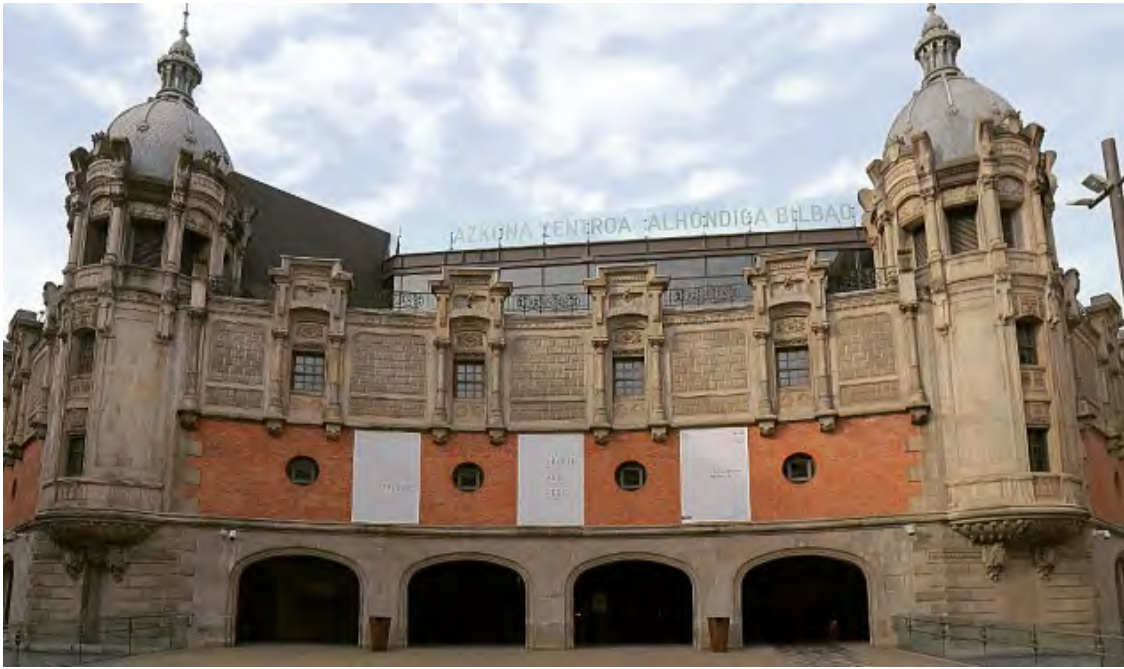
Figura 491. Fotografía del acceso actual del edificio de la ALHÓNDIGA.
