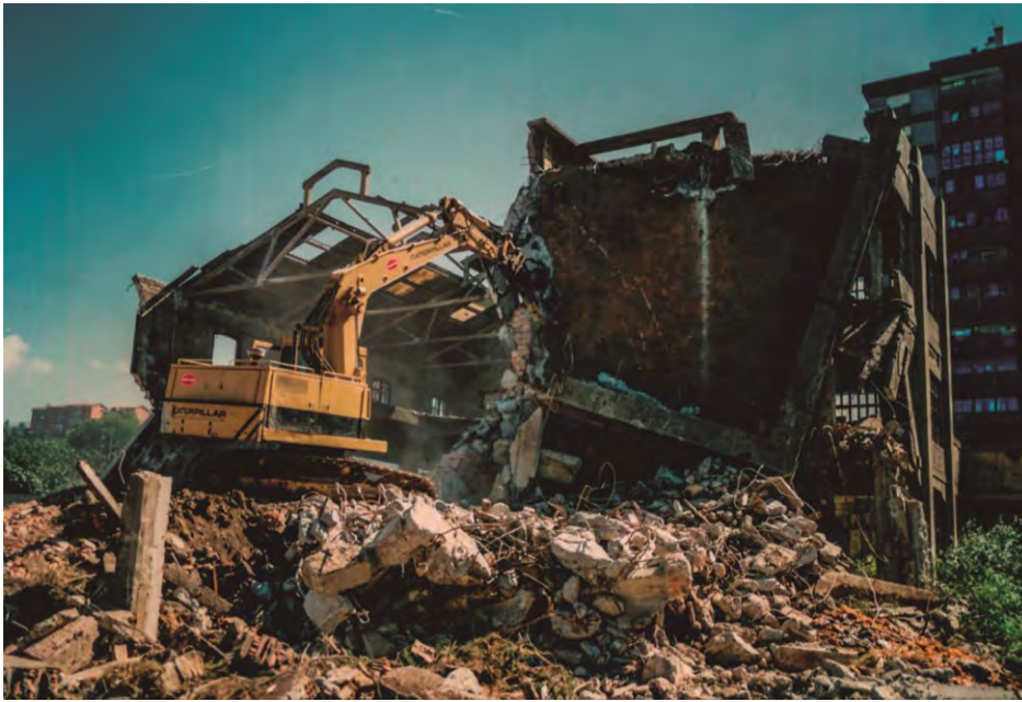
Figura 401. Demolición de la JABONERA TAPIA en 1992.
