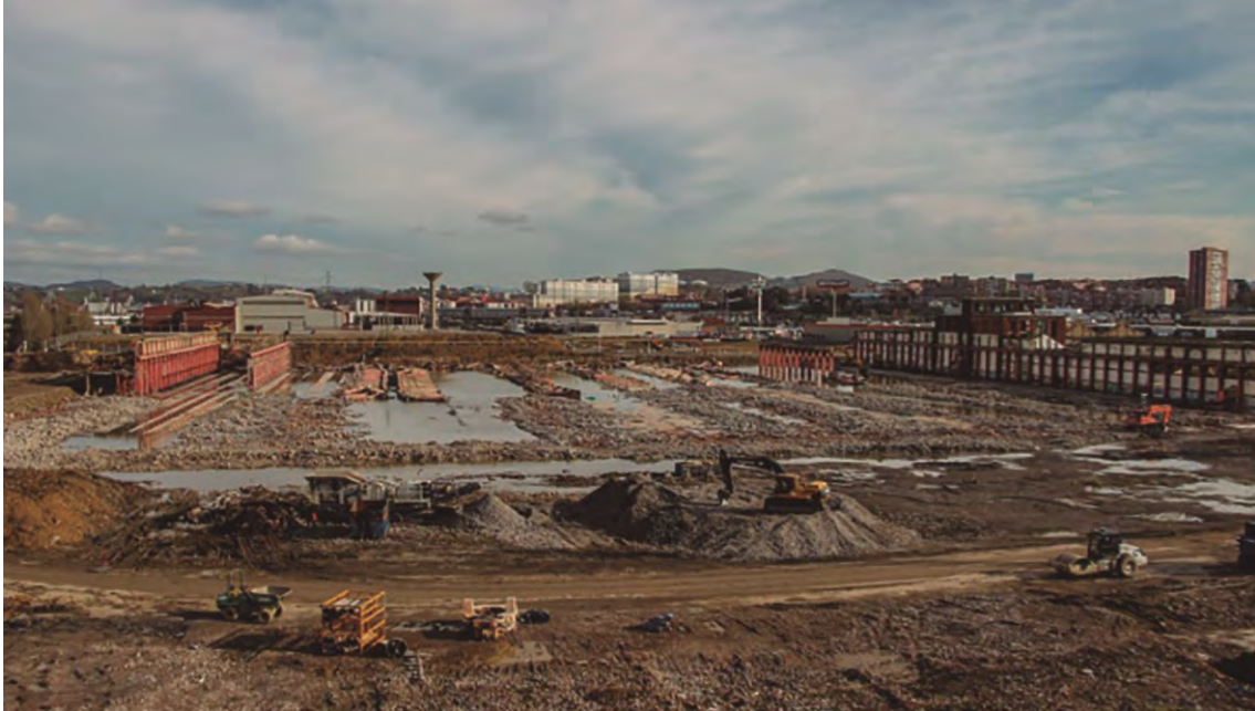
Figura 325. Fotografía de la demolición de las Naves Fundacionales de BWE.
