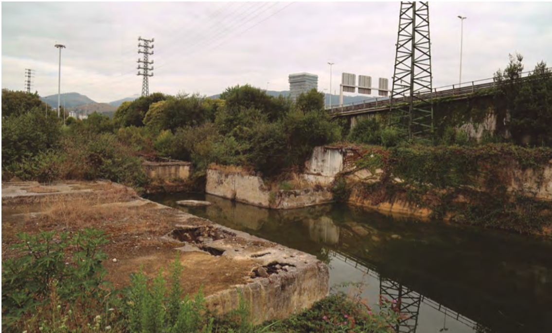
Figura 295. Fotografía del solar vacío tras la demolición de las instalaciones de BEFESA.
