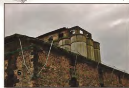
Imagen 7. Relación de fotografías de detalle del estado de conservación general del exterior del Edificio Principal de Grandes Molinos Vascos y del Astillero Real de Zorroza. Ambas edificaciones protegidas muestran un estado de abandono y degradación patente, llegando, en el caso del edificio del Astillero a ser necesaria la colocación de una red anti-desprendimientos anclada a la fachada que da a la calle Marino Archer.
