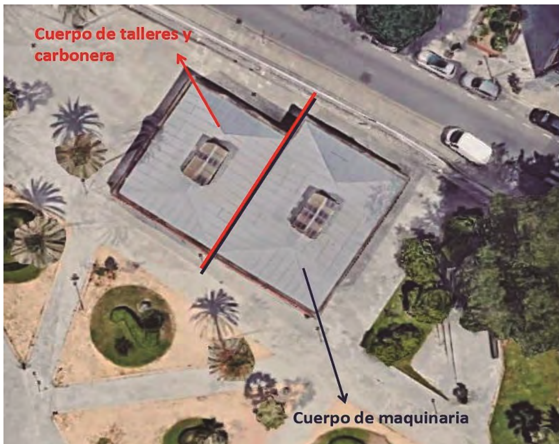
Figura 583. Vista aérea del inmueble de la BOMBEADORA DE AGUAS DE ELORRIETA. En esta vista se observan los dos cuerpos que componen la edificación.
