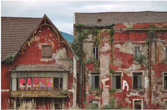
Figuras 169 y 170. Fotografías que muestran en detalle la degradación de las fachadas y las cubiertas y el detalle la degradada fachada del Edificio de Oficinas y Vivienda.
