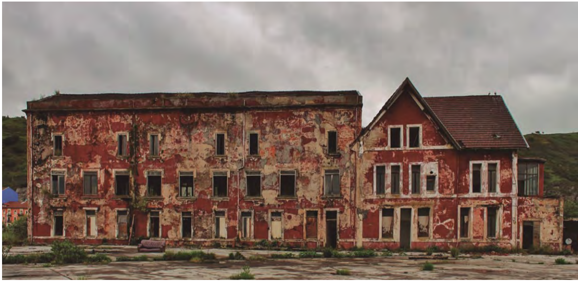
Figura 168. Fotografía de las fachadas de los edificios adosados de vivienda y de oficinas del Conjunto Monumental de los TALLERES DE ZORROZA.
