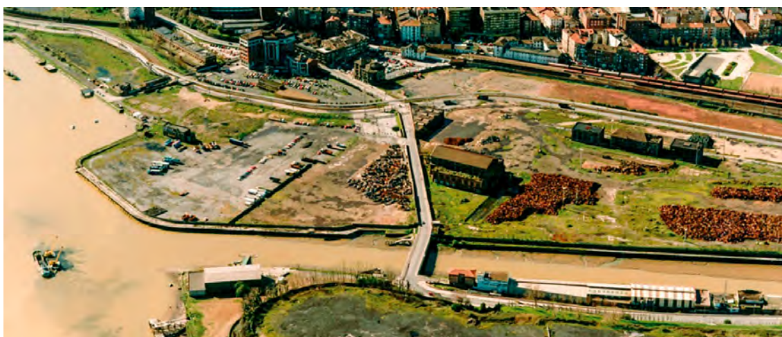
Figura 304. Fotografía del solar de AHV en Barakaldo tras la demolición de casi todas sus edificaciones a excepción del Edificio Ilgner.
