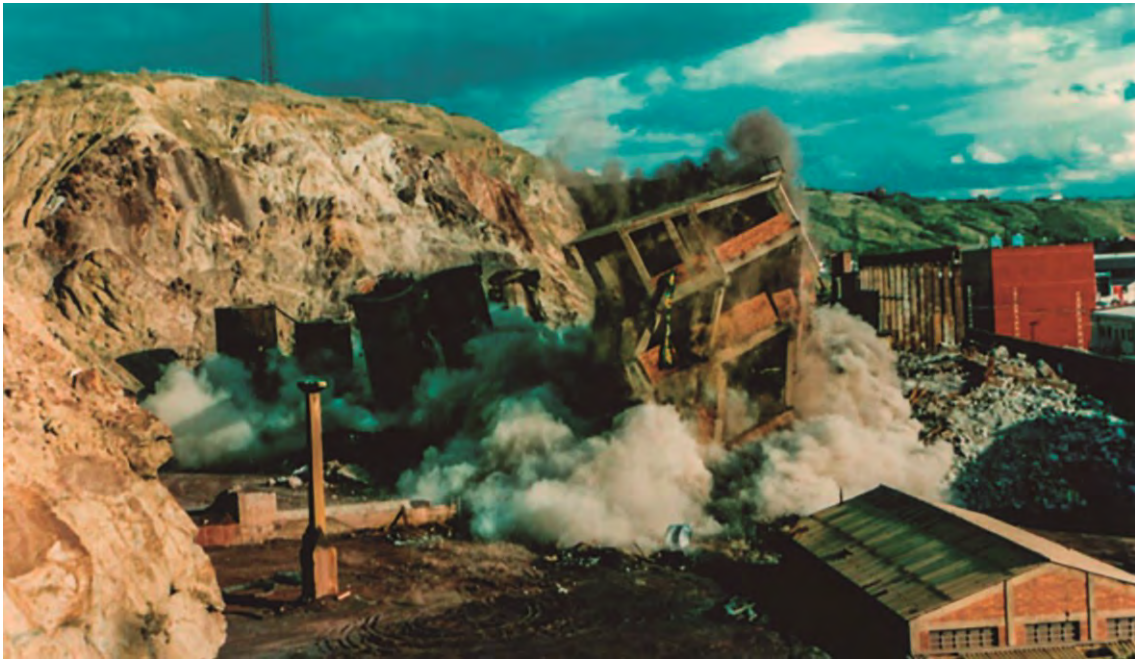
Figura 352. Fotografía de 1993 de la demolición de METALQUÍMICA mediante el PDRRII.
