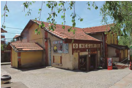
Figuras 180 y 181. Fotografías de dos vistas de la ESTACIÓN DE NEGURI. En la imagen izquierda se muestra la fachada norte, en la que se puede observar el enterramiento parcial de la edificación. En la imagen derecha se muestra la fachada sur con las ventanas y puertas tapiadas y daños en la cubierta.
