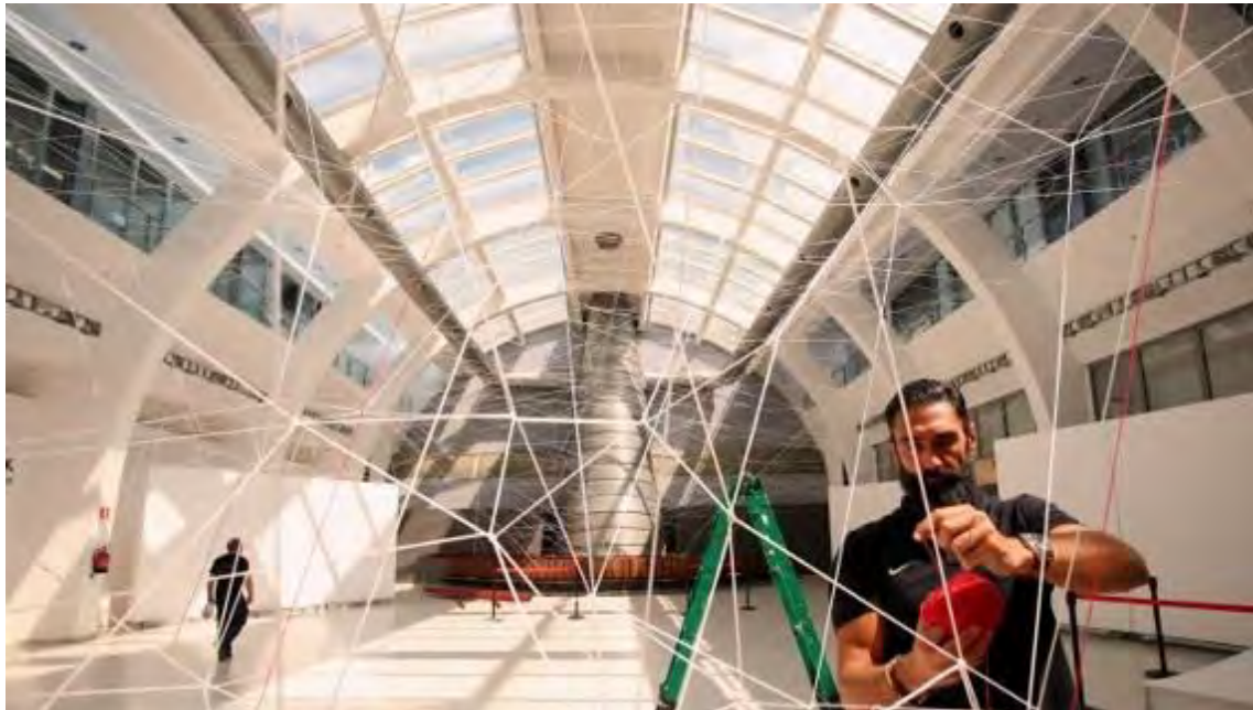
Figura 631. Fotografía publicada en el diario El Correo de la construcción de la estructura red de la obra 13.545 gr.
