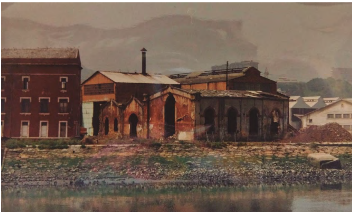
Figura 2. Imagen adjuntada en el anexo del documento “Informe de Ruina” de los pabellones que conforman los Talleres de Zorroza. En la imagen no se aprecia un estado de degradación que justifique un estado de ruina física irreparable. En esta imagen, también se aprecia la acumulación de material en el área protegida de este BC (Fuente: Expediente 01 1096 000002).
