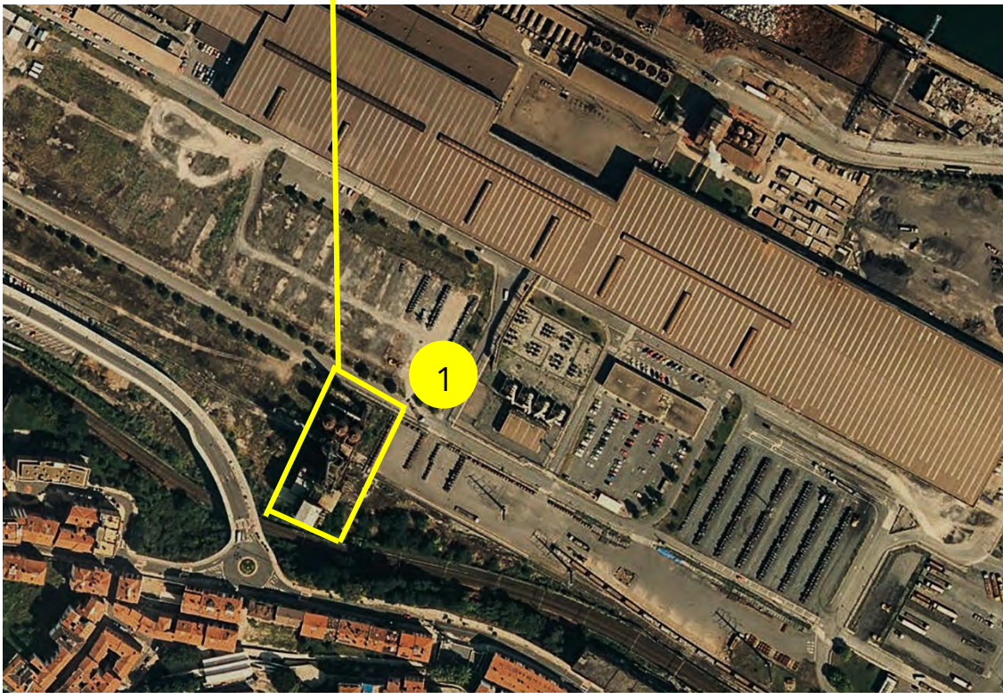
Figuras 91 y 92. Comparativa ortofotográfica entre los espacios donde se ubicaban los hornos altos de AHV. En la imagen superior (1995), se pueden ver los tres hornos altos: el Horno Alto N°1 perimetrado en amarillo, el Horno Alto N°2, perimetrado en azul, y el Horno Alto 2A (M a Ángeles), perimetrado en rojo. En la imagen inferior (2019), se puede observar que únicamente el Horno Alto N°1 sigue en pie.
