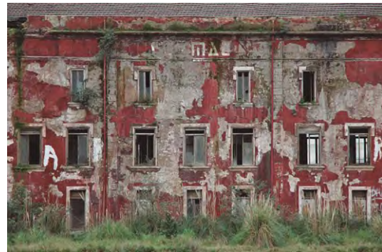
Figuras 169 y 170. Fotografías que muestran en detalle la degradación de las fachadas y las cubiertas y el detalle la degradada fachada del Edificio de Oficinas y Vivienda.
