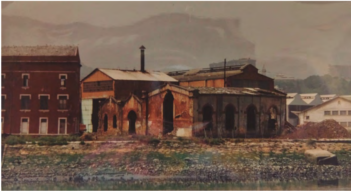
Figura 150. Expediente 01 1096 000002. Fotografía adjuntada en el anexo del documento “Informe de Ruina” de los pabellones que conforman los TALLERES DE ZORROZA, incluido el de Metal Dployé. En la imagen no se aprecia un estado de degradación que justifique un estado de ruina física irrecuperable. A la izquierda de la imagen aportada se puede apreciar la acumulación de material en el área protegida de este BC, lo que probaría su uso negligente y una ilegalidad flagrante.
