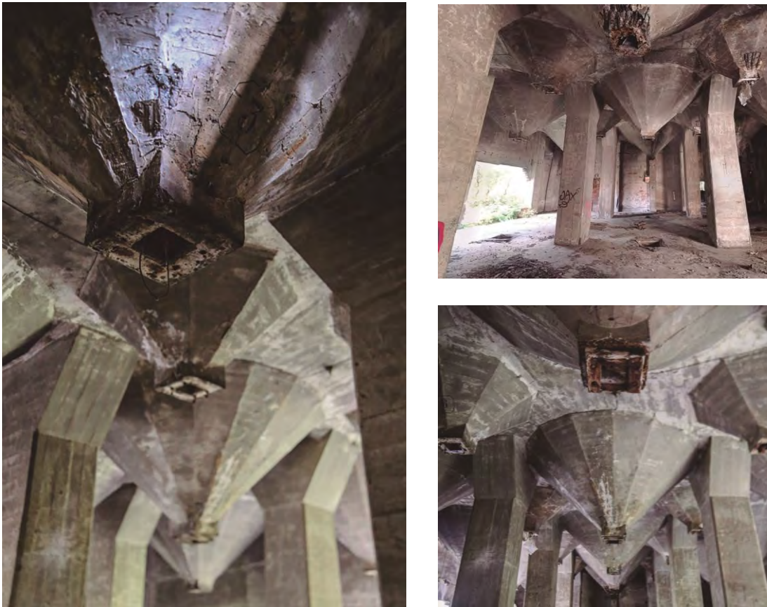
Figuras 185, 186 y 187. Fotografías de la sala de bocas de los silos de GRANDES MOLINOS VASCOS.
