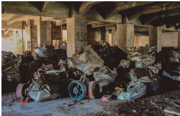
Figuras 199 y 200. Fotografías que muestran la situación de abandono en que se encuentran los modelos de AHV, afectados por las filtraciones de agua debido a la desaparición de parte de la cubierta del Edificio Principal de GRANDES MOLINOS VASCOS.
