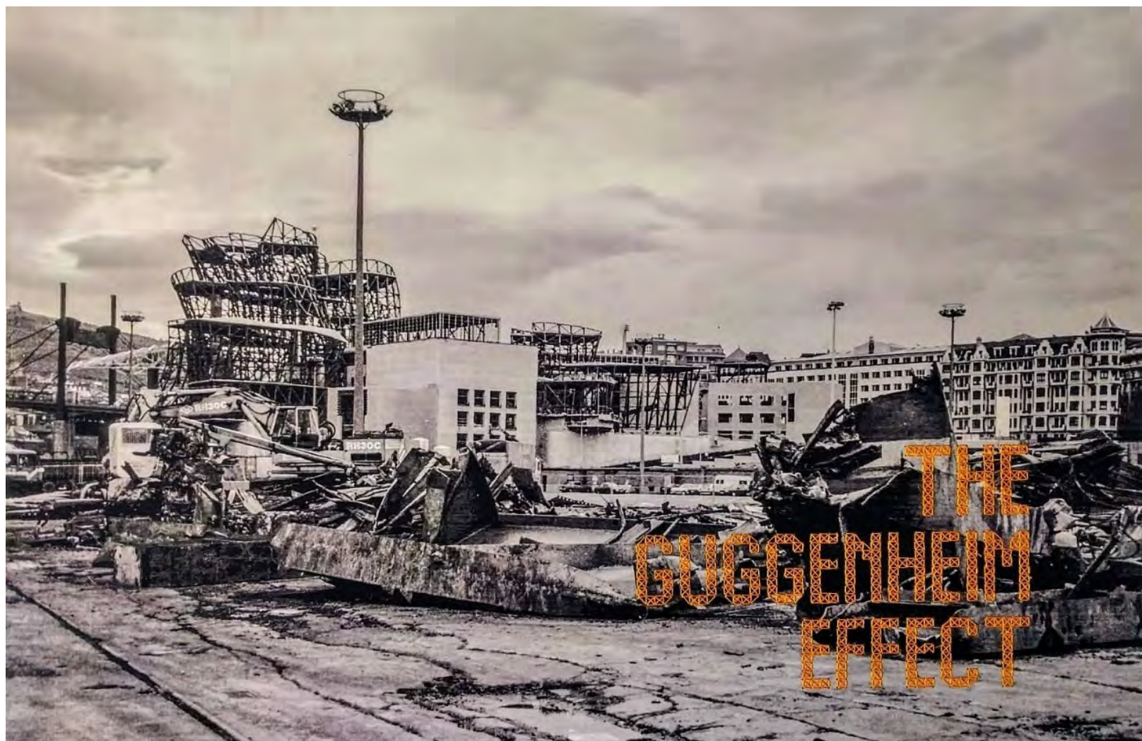
Figura 795. Salcedo, A. (2021). The Guggenheim effect [Fotografía intervenida].
