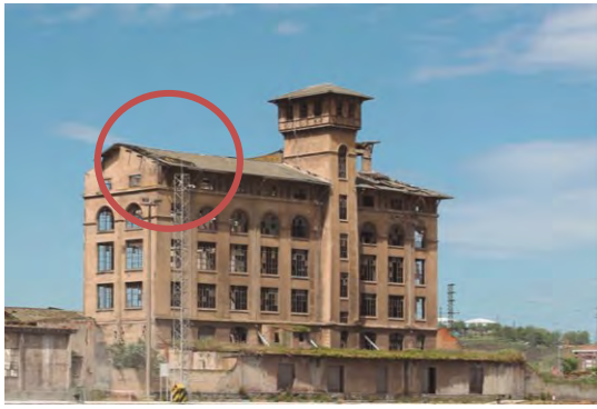
Figuras 194 y 195. Comparativa fotográfica del avance en la degradación de las cubiertas del Edificio Principal durante esta investigación. La imagen izquierda, de 2018, muestra el principio de degradación en el frontal de la cubierta principal. En la imagen derecha, de 2021, se aprecia el derrumbe de parte de la estructura de la cubierta frontal del Edificio Principal. El estado de abandono y degradación de este monumento es notorio y visible.
