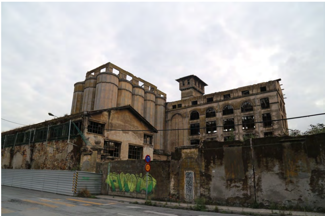
Figura 118. Fotografía de la parte trasera de GRANDES MOLINOS VASCOS. En el muro perimetral del complejo aún se aprecian los huecos tapiados de lo que fueron puertas y ventanas del Edificio de Oficinas y Vivienda.
