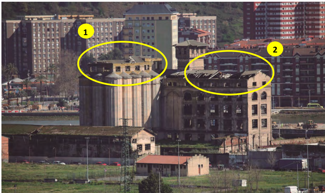
Imagen 1. Fotografía de la parte trasera del complejo de Grandes Molinos Vascos en la que se aprecia la grave degradación de las cubiertas de la edificación patrimonial. La cubierta de los silos (1) ha desaparecido totalmente, mientras la de la fábrica de pisos (2) tiene daños irreversibles. 2021. Fuente: Alberto Salcedo.
