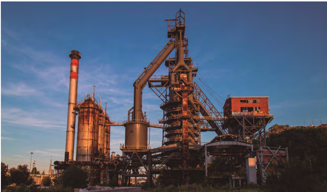
Figura 318. Fotografía del Horno Alto n°1 de AHV en Sestao. BC calificado con la categoría de Monumento .
