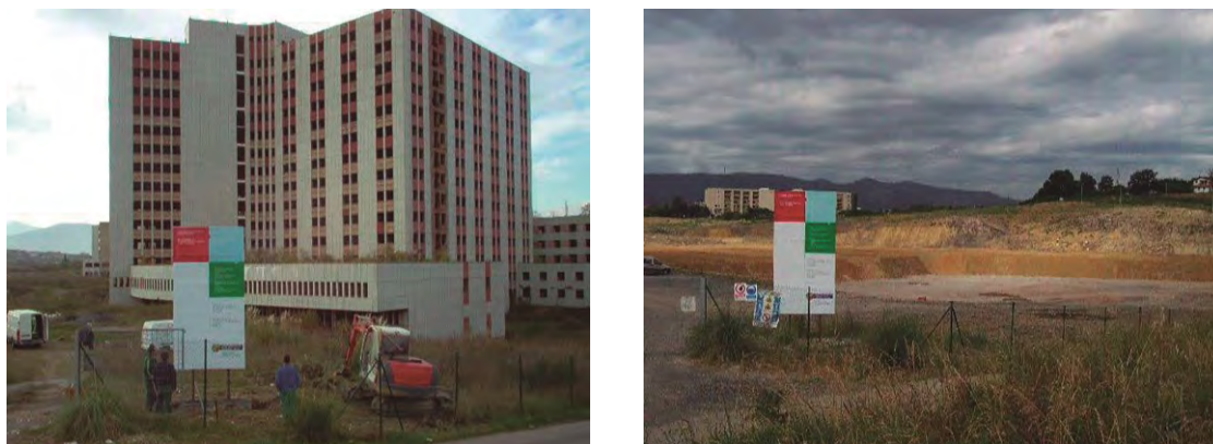
Figura 133 Y 134. Comparativa Fotográfica del antes y el después de la demolición de las edificaciones del Hospital de Leioa. En ambas imágenes se puede observar el característico cartel del PDRRII en el acceso del centro hospitalario.
