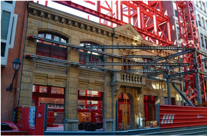
Figura 438. Fotografía de 2018 de las obras del Centro Municipal de Distrito con la estructura frente a la fachada del LAVADERO DE BARRAINKUA.
