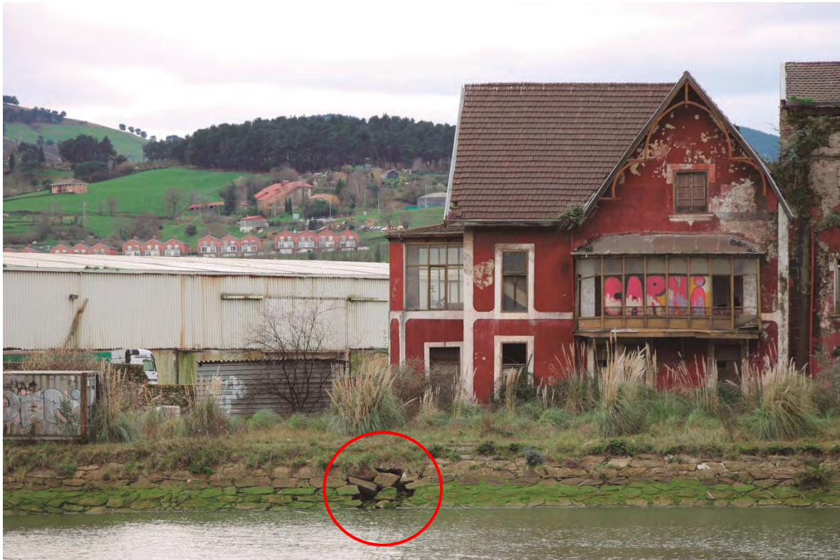
Imagen 23. Fotografía del entorno protegido. En la imagen, rodeado con un círculo rojo, se puede observar un hundimiento en el talud de piedras que separa los edificios protegidos de la ría del Nervión.
