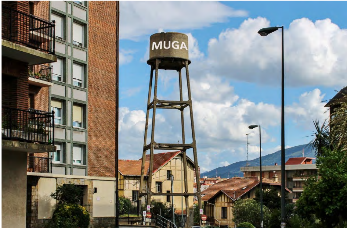
Figura 819. Depósito de aguas de Dolaretxe con la palabra muga sobre su tolva.
