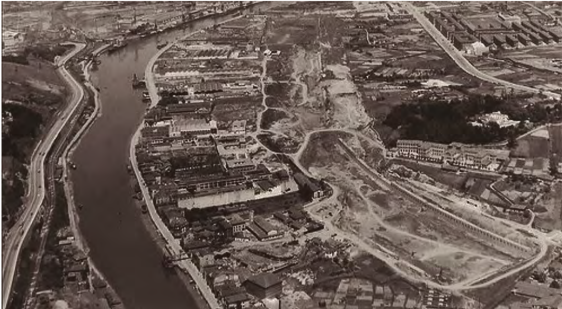
Figura 376. Fotografía del proceso de construcción del Canal de Deusto en 1959.
