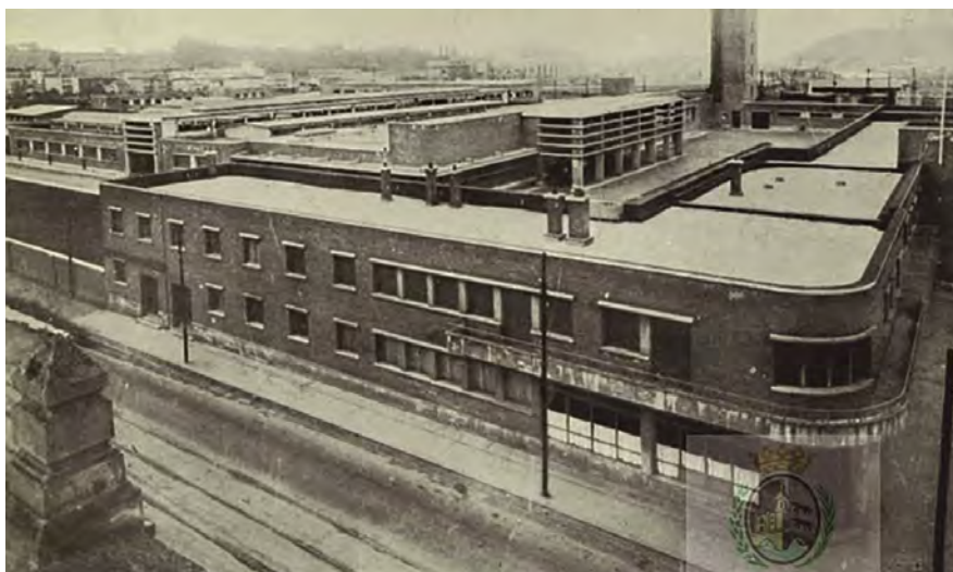
Figura 396. Fotografía del Matadero Municipal de Bilbao en la década de 1950.
