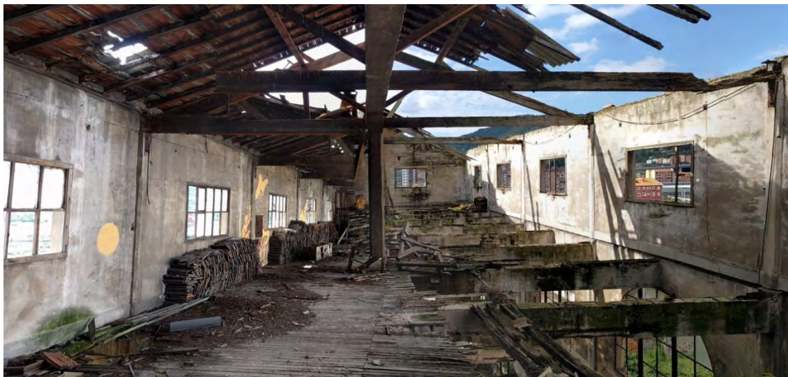
Figura 531. Fotografía actual (2020) del bajo cubierta de la harinera.
