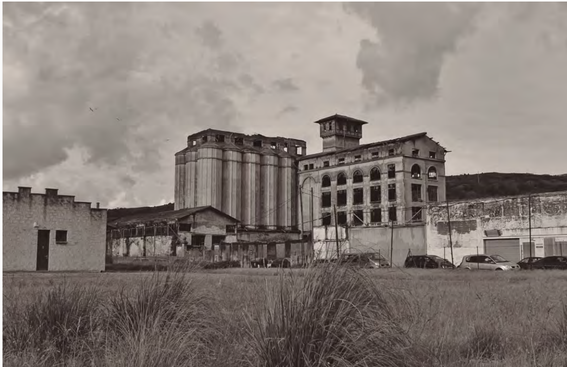
Figura 184. Fotografía de la parte trasera de GRANDES MOLINOS VASCOS, donde se distingue la L que conforman la fábrica de pisos y los silos del edificio principal, el muro el arco de acceso y la nave de la Cordelería del antiguo Astillero Real de Zorroza. Ambas edificaciones llevan décadas abandonadas y manifiestamente degradadas
