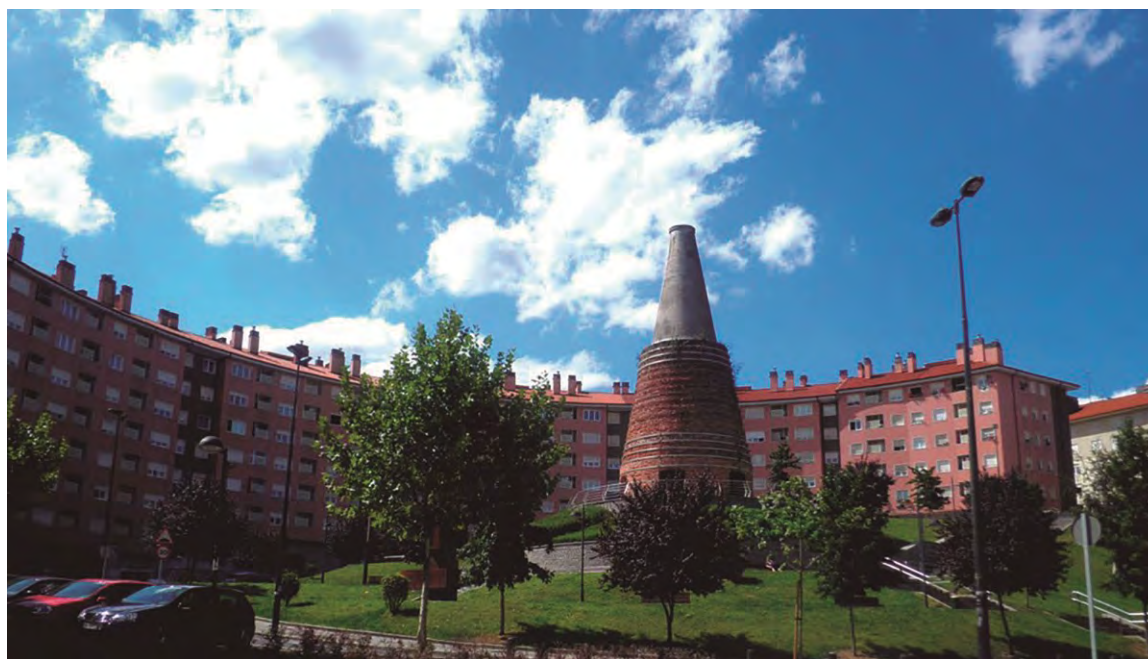
Figura 267. Fotografía del horno de calcinación de la Mina San Luis en la Plaza Saralegi de Bilbao.
