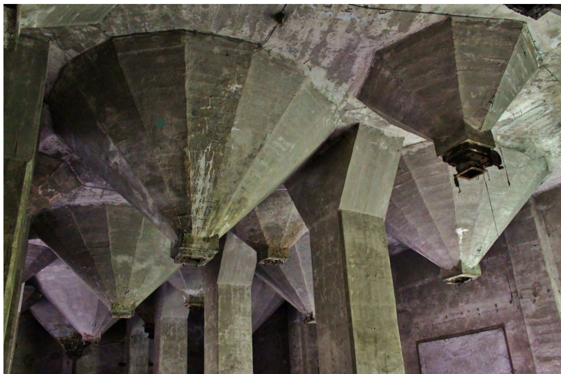
Figura 529. Fotografía del techo de la Sala de Bocas de GRANDES MOLINOS VASCOS.
