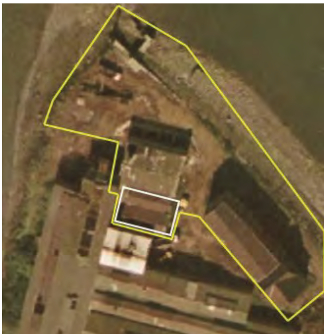
Figura 3. Ortofotografía del complejo de Talleres de Zorroza en el año 2002. En la imagen, en la que se marca con una línea amarilla el espacio protegido, se observan los tres inmuebles integrantes del Conjunto Monumental conservando todavía sus cubiertas. Marcado con perfil blanco se muestran las cubiertas del pabellón de Metal Deployé (Fuente: Geo Euskadi y Alberto Salcedo).
