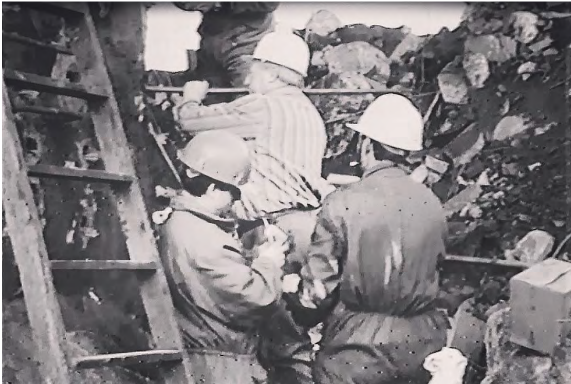
Figura 786. Frame (2'35") extraído del vídeo titulado "Derribo por voladura de 2 chimeneas en Altos Hornos de Vizcaya" (1995).
