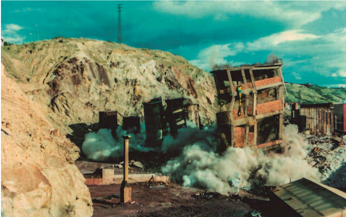
Figura 776. Fotografía de la demolición de la fábrica METALQUÍMICA de Erandio.
