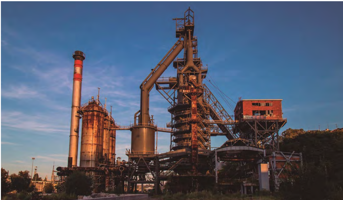
Figura 178. Fotografía que muestra una vista general del Horno Alto N°1 de AHV, en la que se pueden apreciar las huellas de la oxidación.
