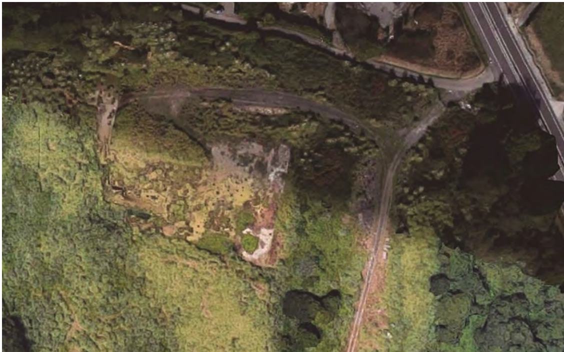
Figura 136. Vista aérea del solar en el que se ubicaba el Hospital, con las huellas de sus cimientos. Hoy en día, permanece vacío y sin un plan de reutilización.
