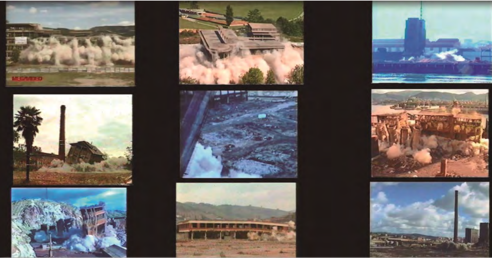
Figura 779. Imagen del bloque-secuencia1 en la prueba del funcionamiento de la instalación
