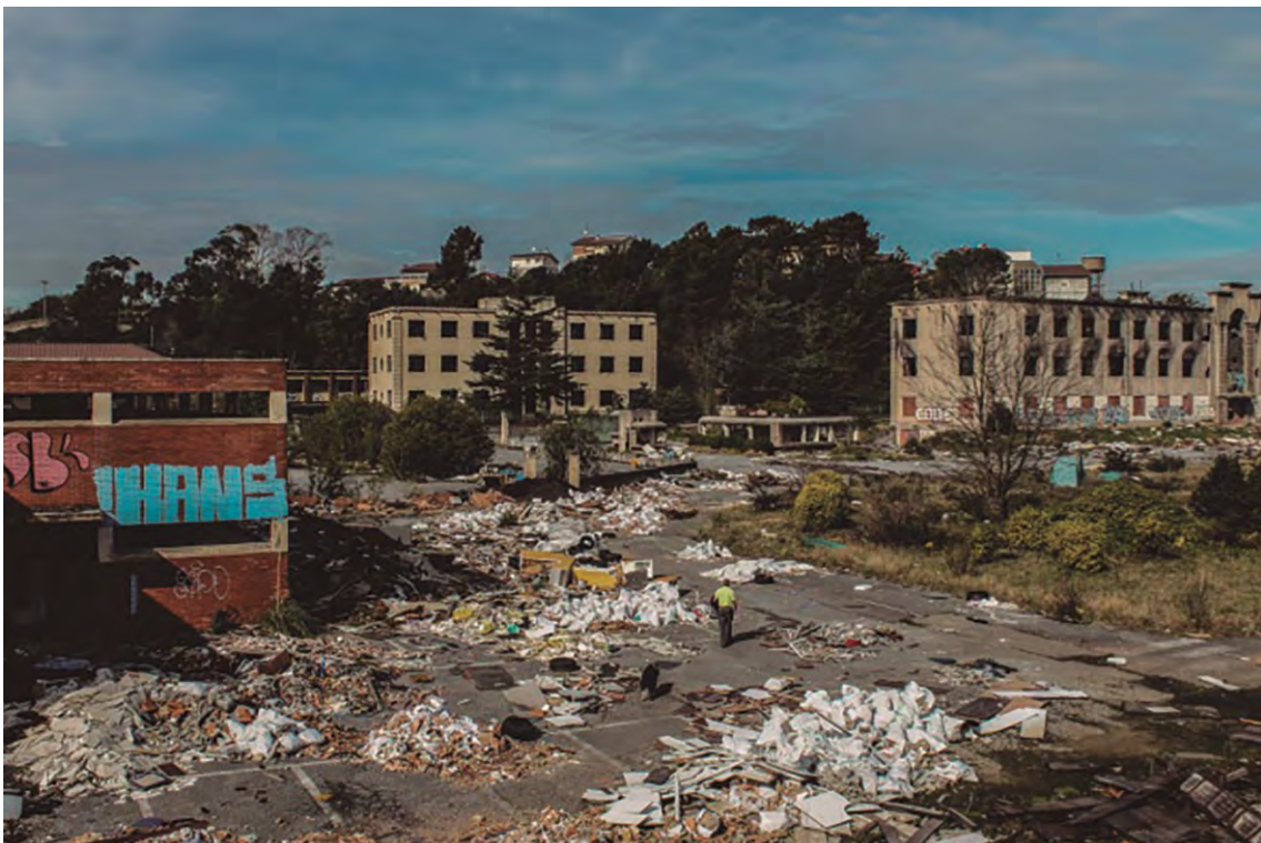
Figura 324. Fotografía de las instalaciones de BWE abandonadas y vandalizadas, empleadas como vertedero ilegal.
