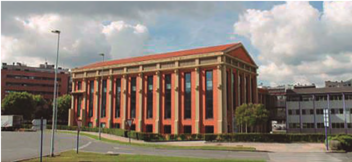
Figura 307. Fotografía del Edificio Ilgner en la actualidad.
