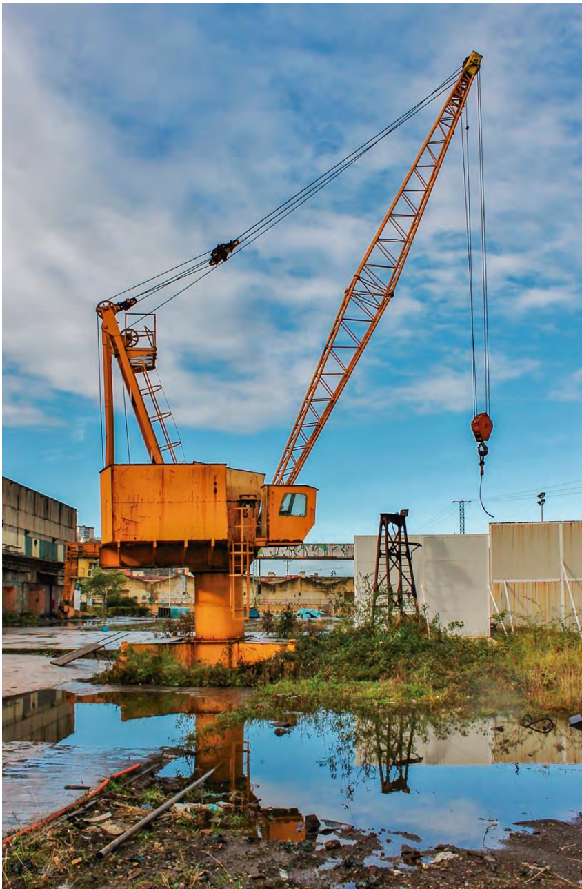
Figura 425. Fotografía de una de las grúas de porte de Vicinay y la torre de vigía. Ambas serán conservadas.
