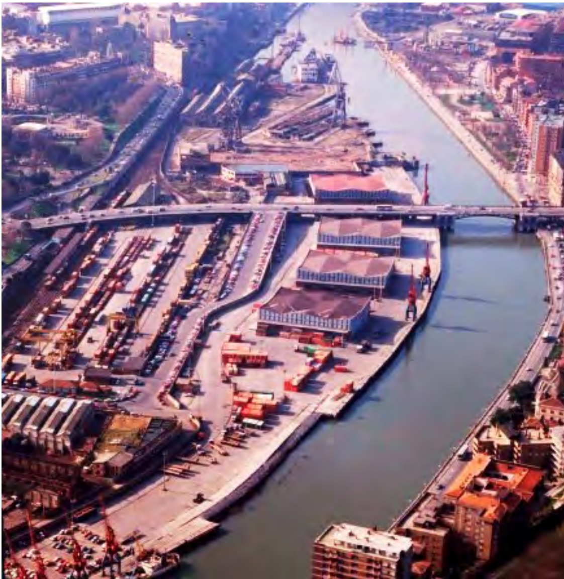
Figura 240. Fotografía aérea que muestra el área de Abandoibarra en su etapa industrial.
