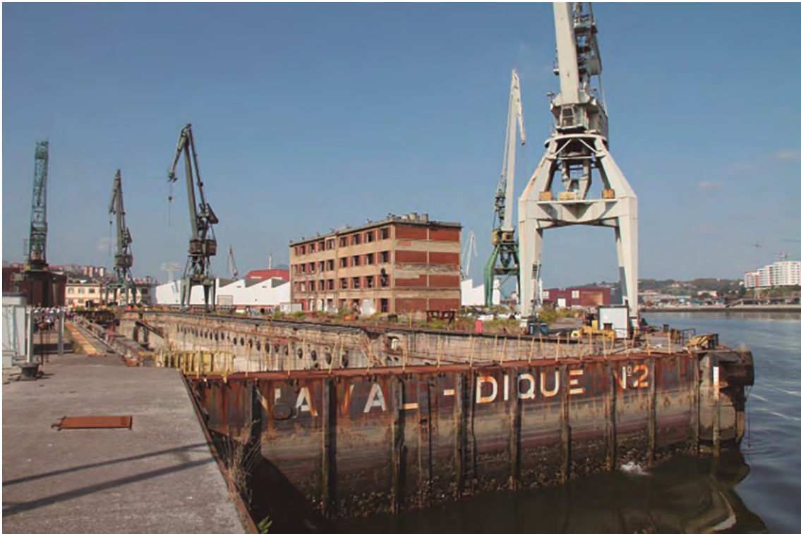
Figura 321. Fotografía del Dique Seco nº2 de LA NAVAL.
