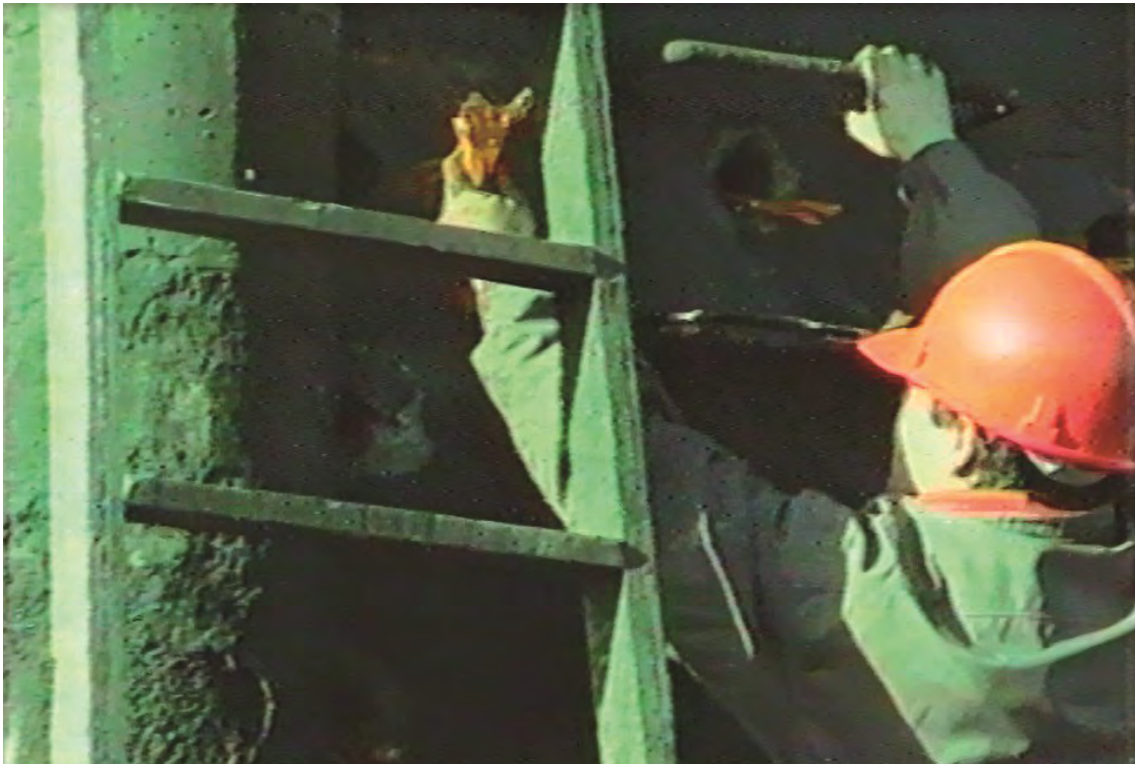
Figura 778. Fotograma del video maestro, en el que uno de los trabajadores de AHV coloca los detonadores de las cargas de Goma 2 colocadas en la base de la chimenea que van a demoler.
