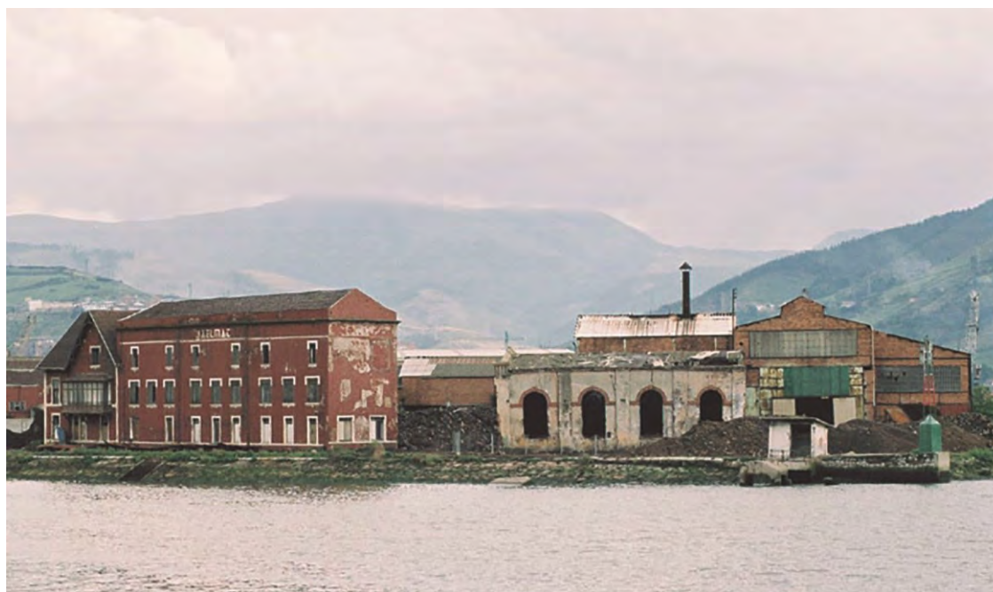
Figura 147. Fotografía extraída de la ficha nº 447 del Inventario de Patrimonio Cultural del País Vasco en la que se demuestra como la propiedad acumulaba escombros y chatarra contra los muros de las edificaciones patrimoniales, invadiendo el espacio protegido de este BC.
