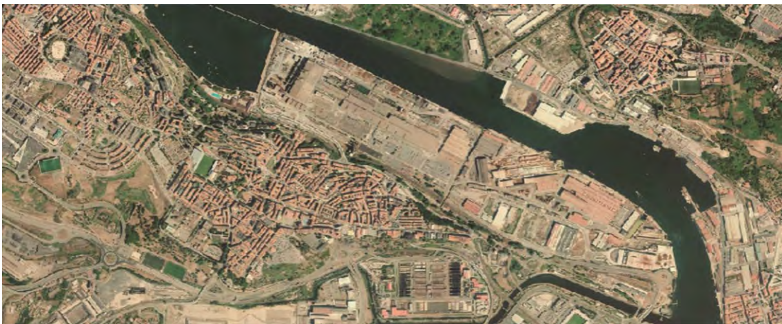
Figuras 310 y 311. Comparativa ortofotográfica de la dársena La Benedicta de Sestao. En la imagen superior, de 1977, se puede observar que la práctica totalidad de este espacio estaba colonizado por instalaciones fabriles y portuarias. En la imagen inferior, de 2019, la ocupación de la dársena es menos intensiva.
