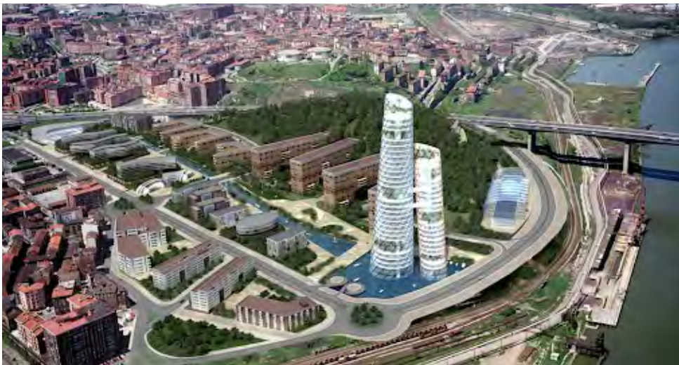
Figuras 288, 289 y 290. Pasado, presente y futuro del área industrial de SEFANITRO y BEFESA. En la imagen superior se muestra el complejo de SEFANITRO en funcionamiento. En la intermedia se aprecia la misma área con las huellas de las edificaciones que se demolieron. En la imagen inferior se muestra una infografía del futuro proyecto de urbanización de este espacio urbano.
