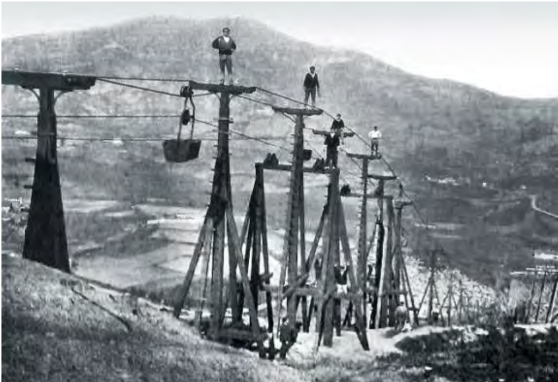
Figura 213. Fotografía de 1883 del sistema de transporte aéreo de mineral de hierro.
