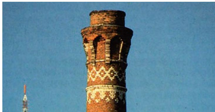
Figura 256. Uriarte, I. (1990). Fotografía de detalle de la corona de la chimenea de la COMPAÑÍA DE MADERAS.
