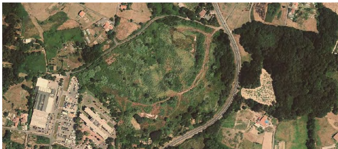
Figuras 131 y 132. Comparativa ortofotográfica del área donde se ubicó el Hospital de Leioa. En la imagen superior se muestra el complejo en 1983; mientras, en la inferior, de 2019, se muestra el solar resultante tras su demolición.
