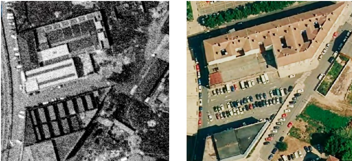
Figuras 345 y 346. Comparativa ortofotográfica de un tramo de la calle Bereterretxe en Erandio, a la izquierda, en 1977, con varios edificios industriales. En la imagen derecha, del año 2019, los solares de dos de estos edificios son reutilizados para construir un aparcamiento público y edificio de viviendas.
