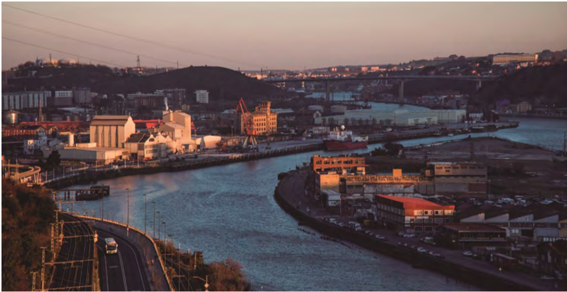
Figura 393. Salcedo, A. (2018). Fotografía del paisaje industrial de la punta norte de Zorrotzaurre y del área de Punta Zorroza, donde se distingue el edificio de GRANDES MOLINOS VASCOS y el complejo de Sader.
