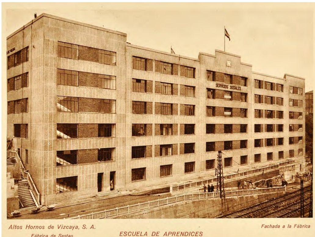
Figuras 62. Fotografía de 1943 de la fachada trasera del edificio denominado de Servicios Sociales, donde se encontraba la escuela de aprendices de AHV.
