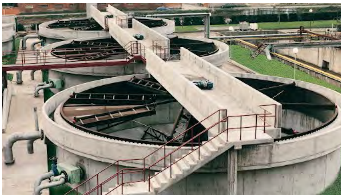
Figura 219. Fotografía de los depósitos de la Estación Depuradora de Galindo.
