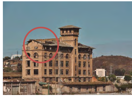
Figuras 194 y 195. Comparativa fotográfica del avance en la degradación de las cubiertas del Edificio Principal durante esta investigación. La imagen izquierda, de 2018, muestra el principio de degradación en el frontal de la cubierta principal. En la imagen derecha, de 2021, se aprecia el derrumbe de parte de la estructura de la cubierta frontal del Edificio Principal. El estado de abandono y degradación de este monumento es notorio y visible.
