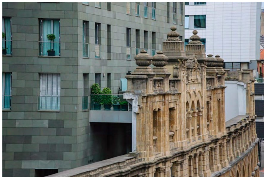
Figura 431. Fotografía de detalle de la utilización de la corona de la portada posterior del DEPÓSITO FRANCO DE URIBITARTE como balaustrada de los balcones del nuevo edificio de viviendas.
