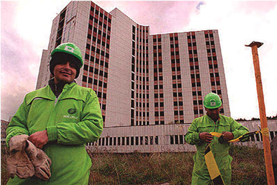
Figura 366. Fotografía de los operarios de la empresa de demoliciones antes de derribar el Hospital de Leioa.
