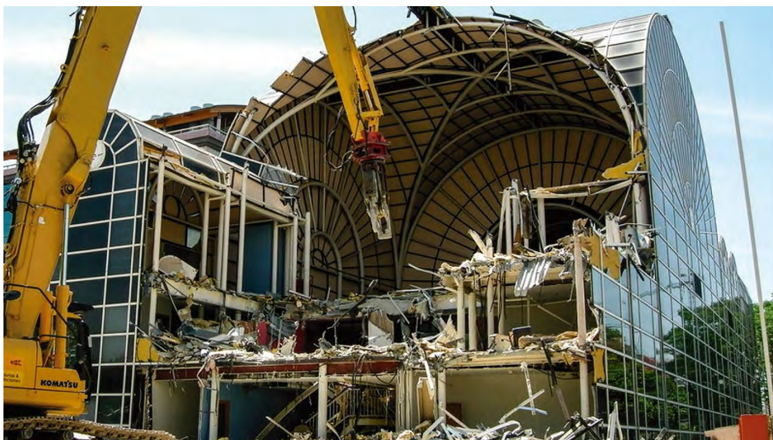
Figura 70. Fotografía de la demolición del pabellón de la Santa Sede en la Expo'92 de Sevilla.
