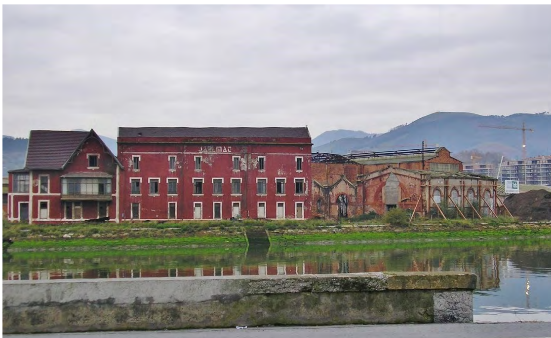
Figura 5. La imagen muestra los pabellones de La Central de Fuerza y de Metal Deployé apuntalados y aún en pie (Fuente: Centro de Patrimonio Cultural del Gobierno vasco).
