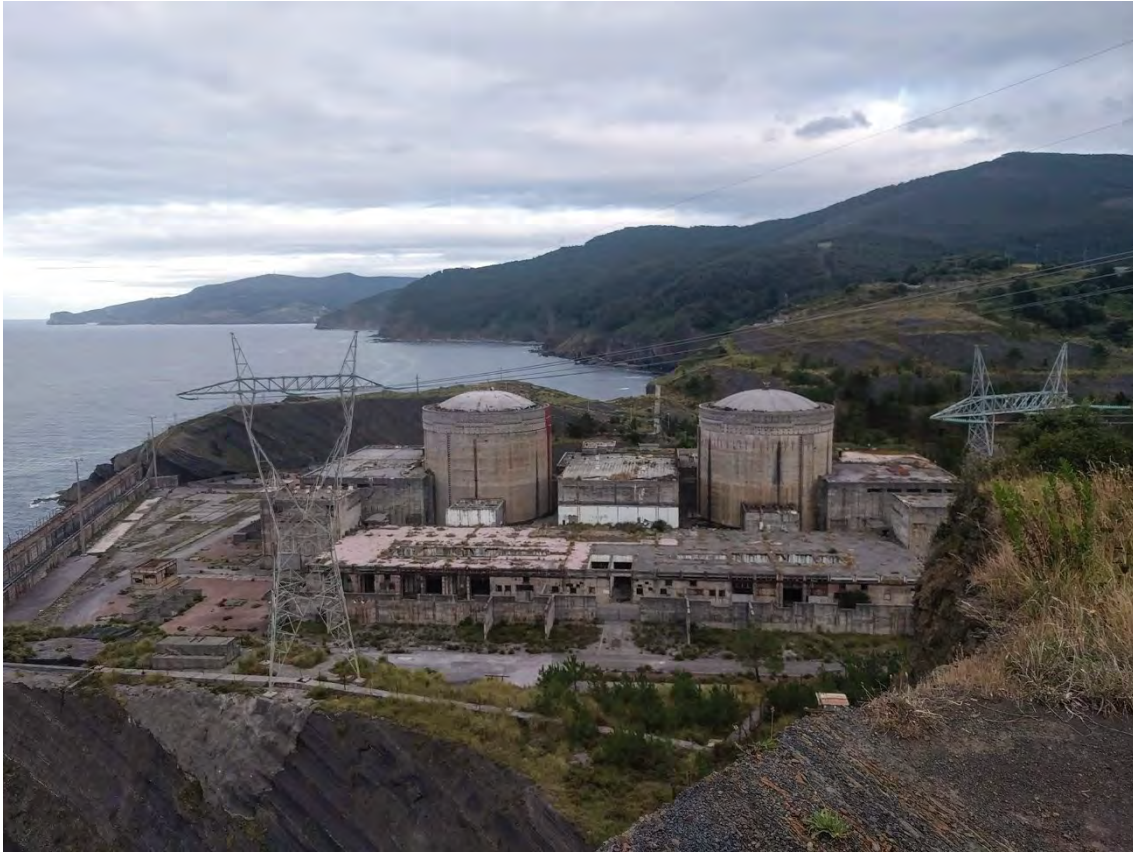
Figura 69. Fotografía del complejo de la CENTRAL NUCLEAR DE LEMÓNIZ.
