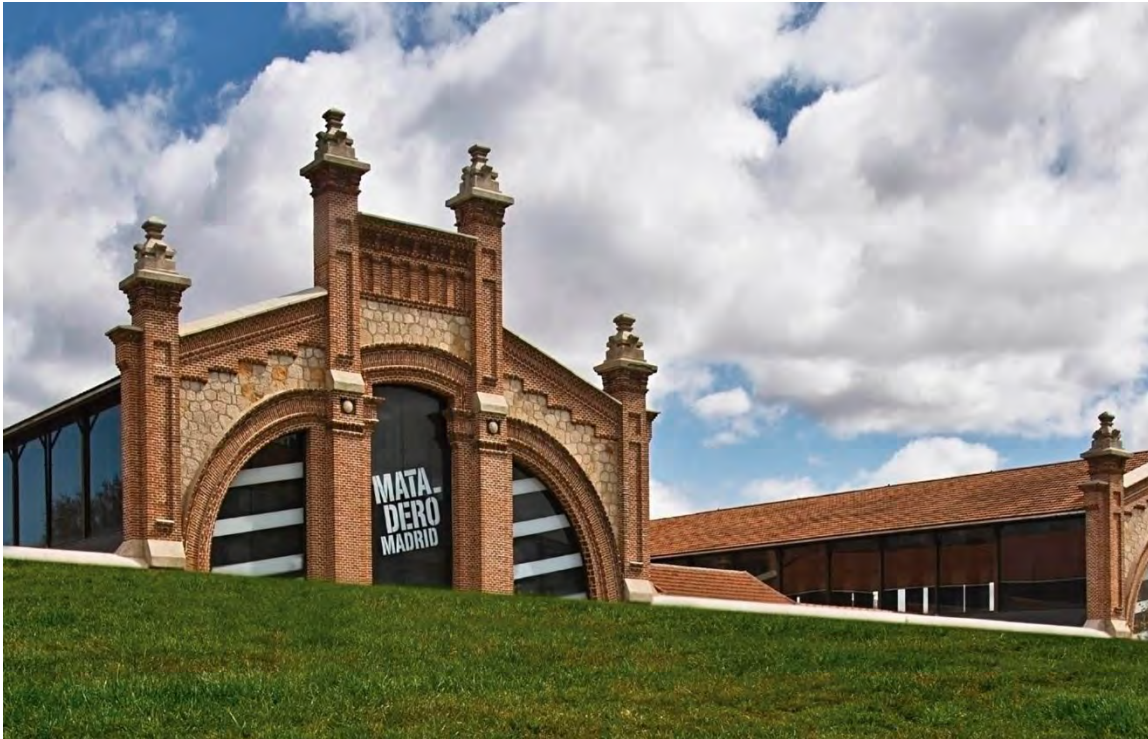
Figura 476. Detalle de la fachada de Matadero Madrid .
