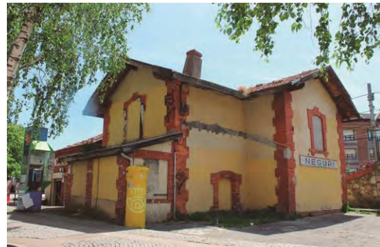
Figuras 180 y 181. Fotografías de dos vistas de la ESTACIÓN DE NEGURI. En la imagen izquierda se muestra la fachada norte, en la que se puede observar el enterramiento parcial de la edificación. En la imagen derecha se muestra la fachada sur con las ventanas y puertas tapiadas y daños en la cubierta.
