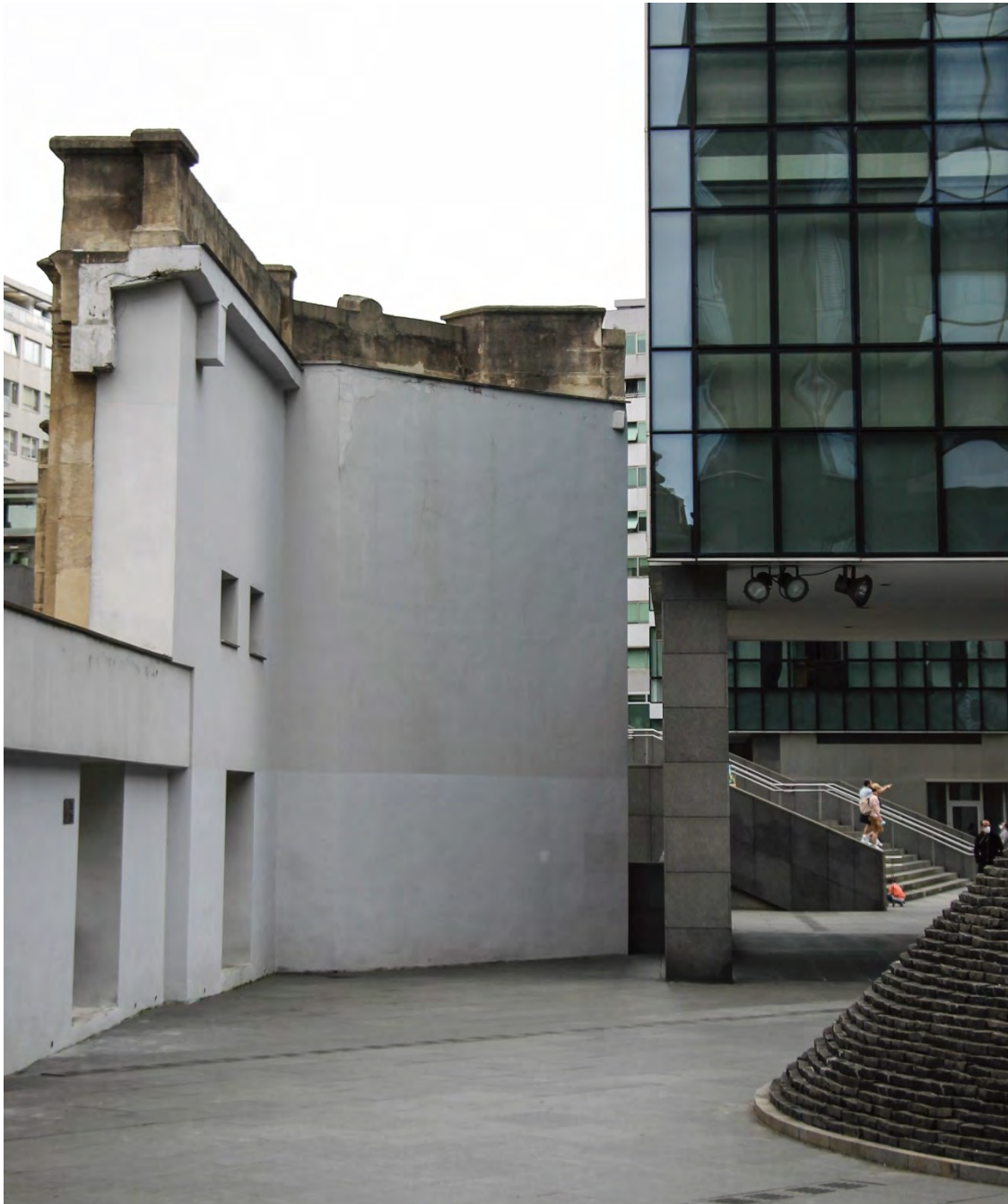
Figura 432. Fotografía del tratamiento interior del muro del DEPÓSITO FRANCO DE URIBITARTE y su encaje con las nuevas edificaciones.
