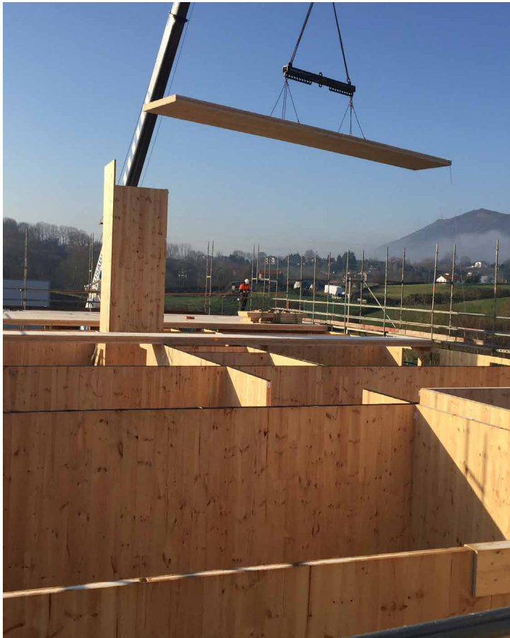
← CLT forjatuaren muntaketa.
