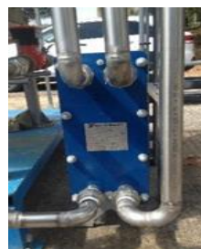
Figura 4.9b. Intercambiador de calor.
