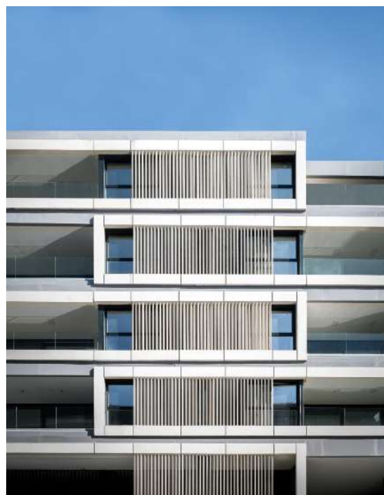
Imagen 1-1. Instalación de paneles prefabricados de INDAGSA
