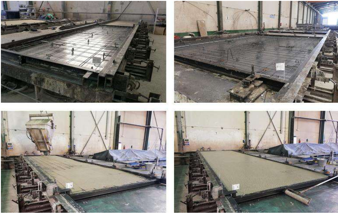
Imagen 2-1. Etapas de la fabricación del panel prefabricado de hormigón.
