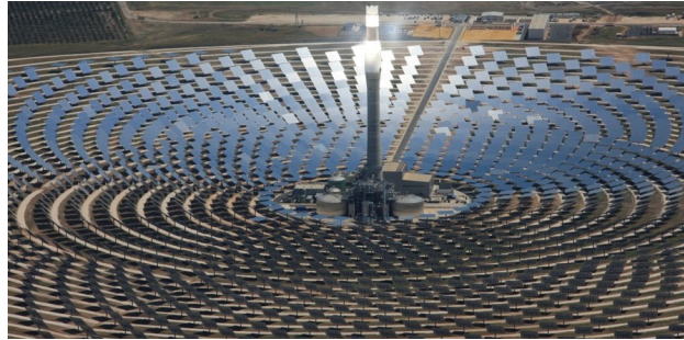
Figura 1: Gemasolar, instalación de GSC española en Sevilla.
